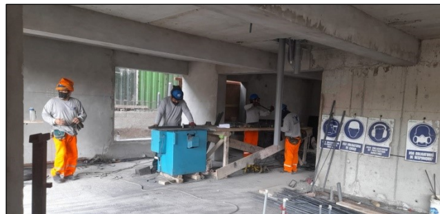
Figura 4-19: Máquina dobladora empleada en caso de contingencia Fuente: Elaboración propia
