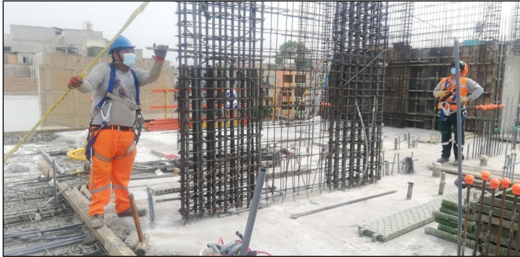
Figura 5-19: Instalación de elementos prearmados de placa a 2 Niveles en condominio Esencial. Fuente: Elaboración propia
