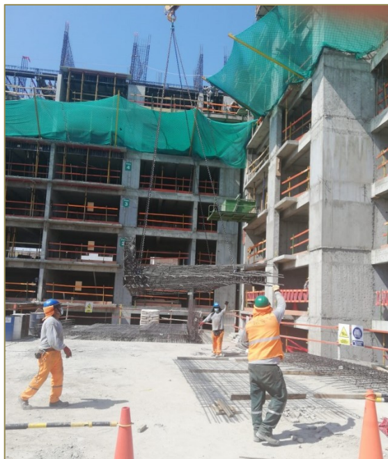
Figura 5-18: Montaje de elementos verticales prearmados. Fuente: Elaboración propia
