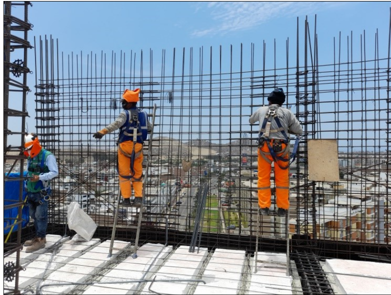
Figura 3-13 : Instalación de placa – empalme de zunchos. Fuente: Aceros Arequipa
