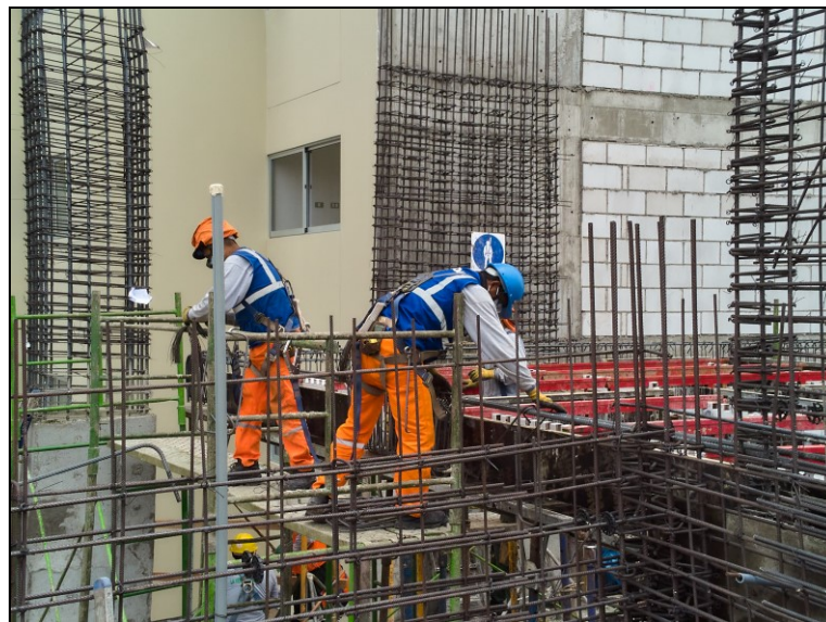
Figura 3-14 : Instalación de acero dimensionado de vigas. Fuente: Aceros Arequipa
