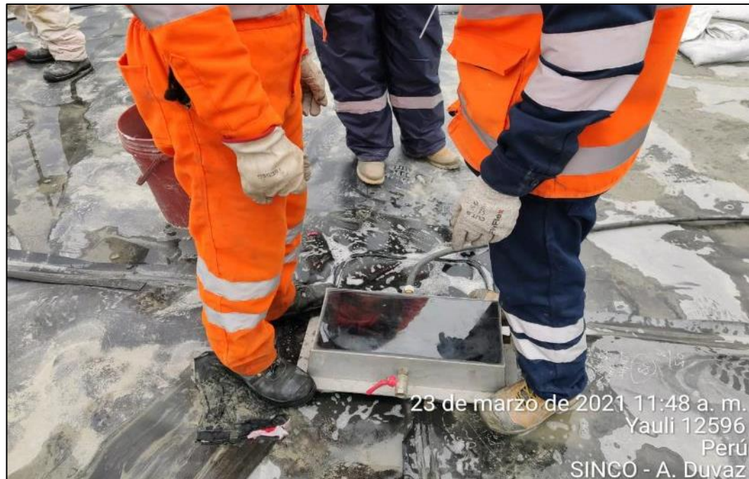
Figura 30: Control de calidad de costuras con cámara de vacío
