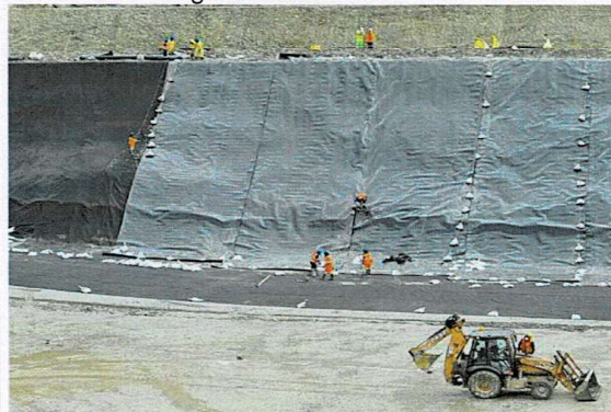
Colocación de geosintéticos
