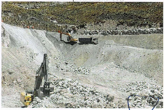
Conformación de banquetas zona este
