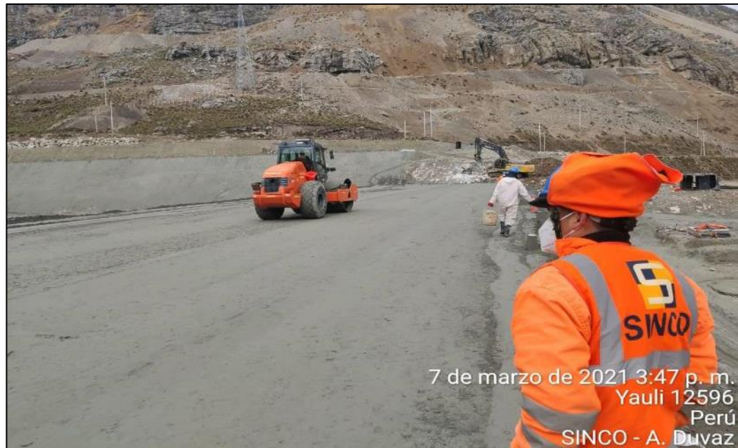
Figura 26: Inspección de los ciclos de compactación de capas
