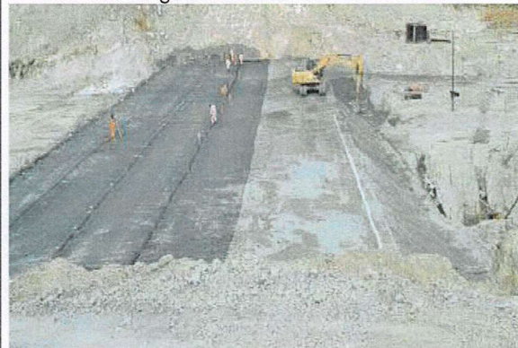
Perfilado manual de talud
