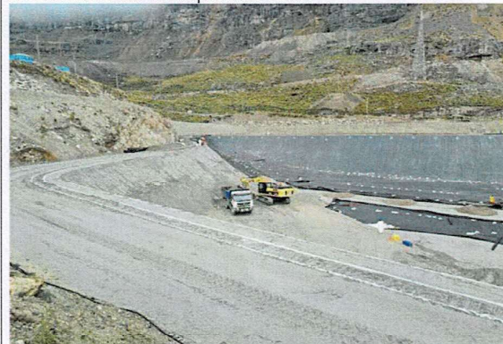
Perfilado de talud dique principal
