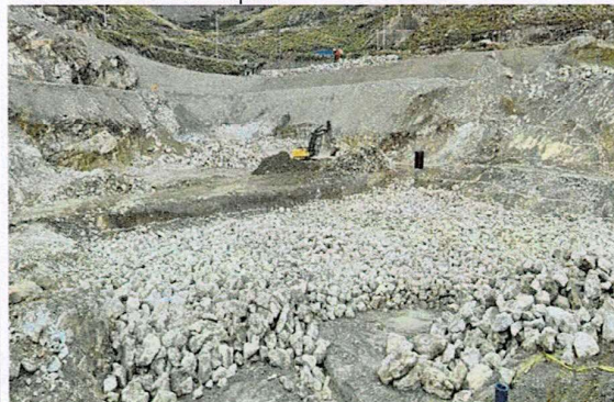
Conformación de dique de arranque
