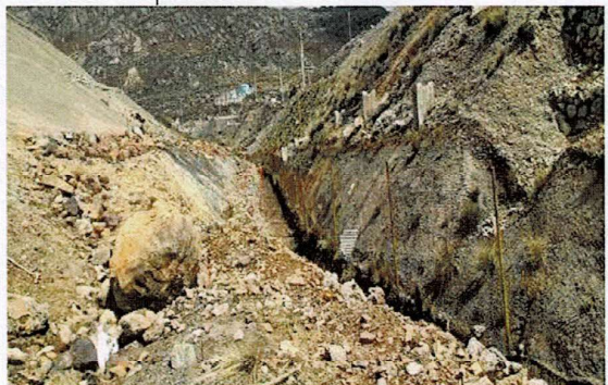
Construcción de canal de coronación
