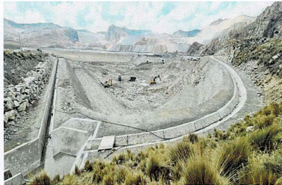
Construcción de canal de coronación
