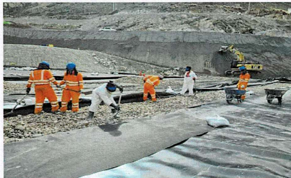
Impermeabilización del vaso
