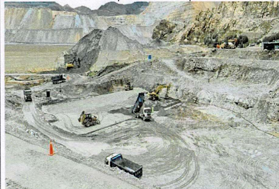
Conformación de dique de arranque
