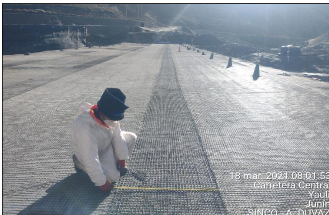
Figura 29: Verificación de traslape en geomallas de refuerzo del dique
