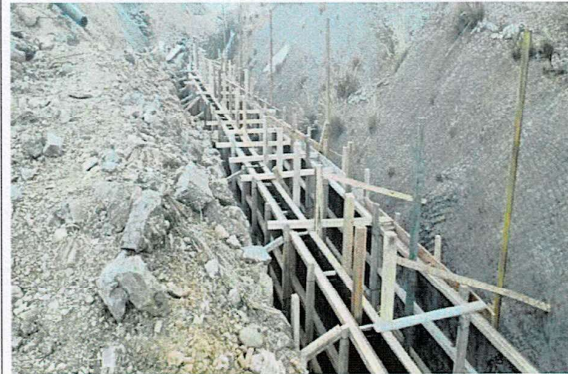
Encofrado de canal de concreto armado
