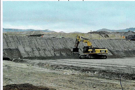
Perfilado de talud dique principal
