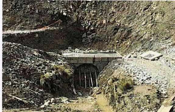
Construcción de tapón de bocamina
