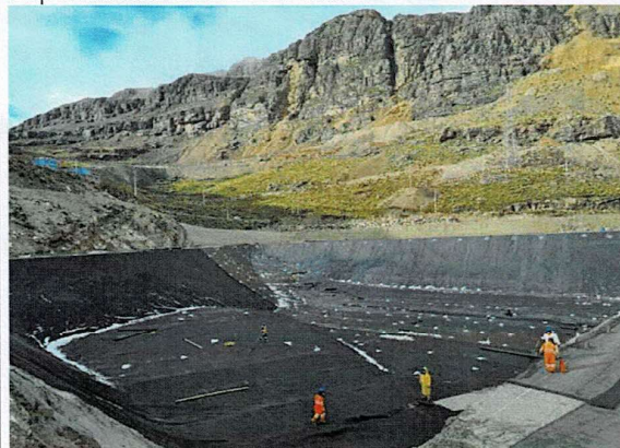
Impermeabilización del vaso
