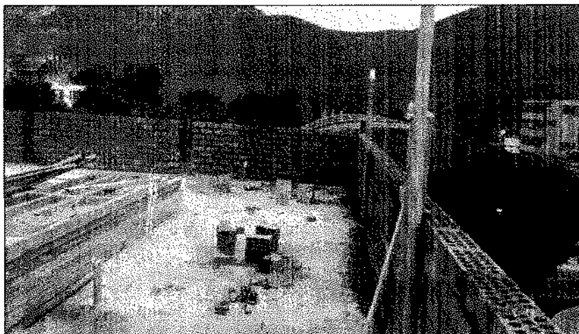
Foto N° 10: Asentado de muro parapeto de azotea.
