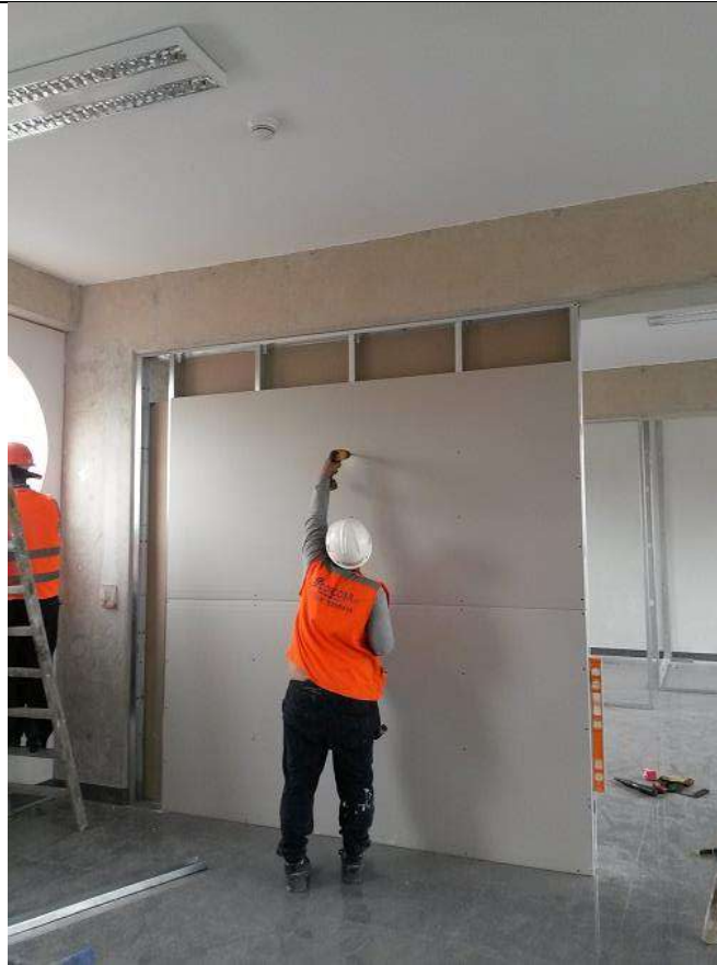
Instalación de tabiquería de Drywall
