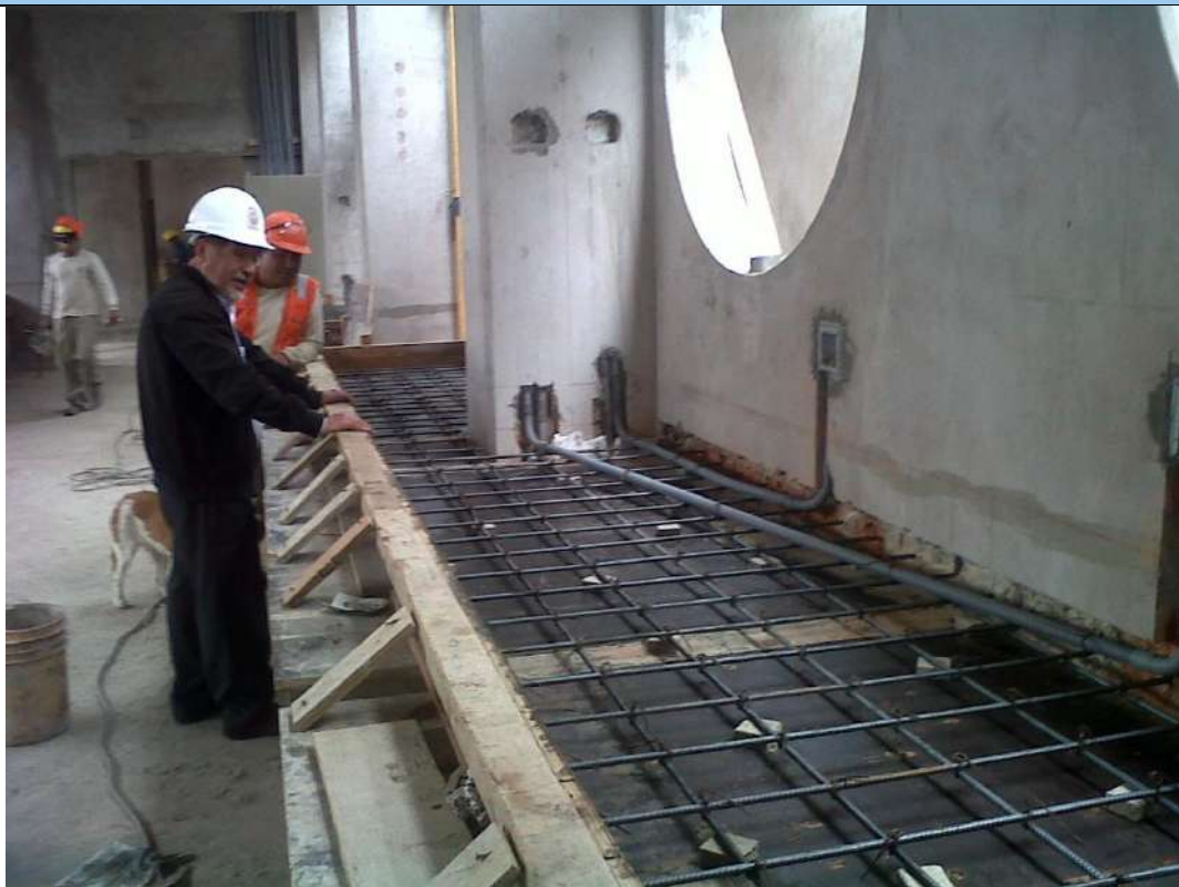
Verificación de las mesetas de concreto por parte del Supervisor de la Obra
