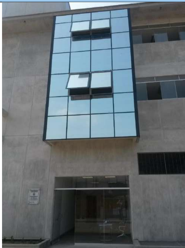
Instalación de muro cortina en fachada de la obra
