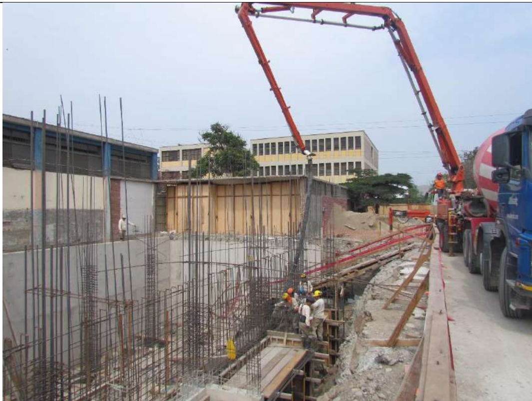
Vaciado de concreto en muros de contención de sotano
