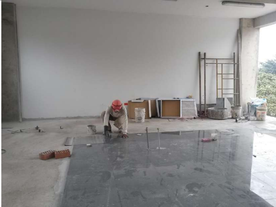
Instalación de porcelanato en 2do y 3er piso de la obra
