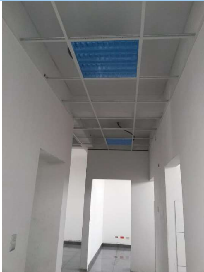
Instalación de falso cielo raso con baldosas acústicas
