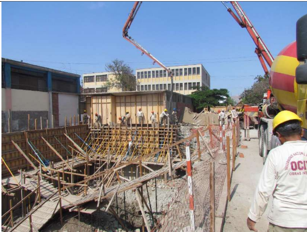
Vaciado de concreto en muros de contención de sótano
