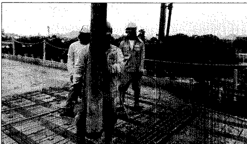
Foto N° 7: Colocado de concreto
