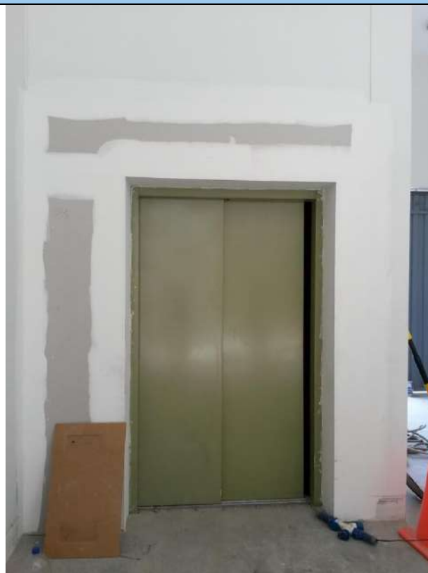
Instalación de Ascensor de 1000 Kg de capacidad
