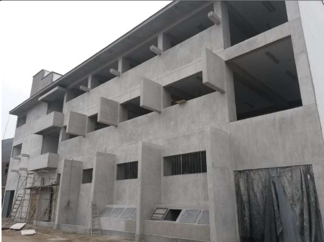
Fachada culminada luego de tarrajeo de muros y solaqueado de placas
