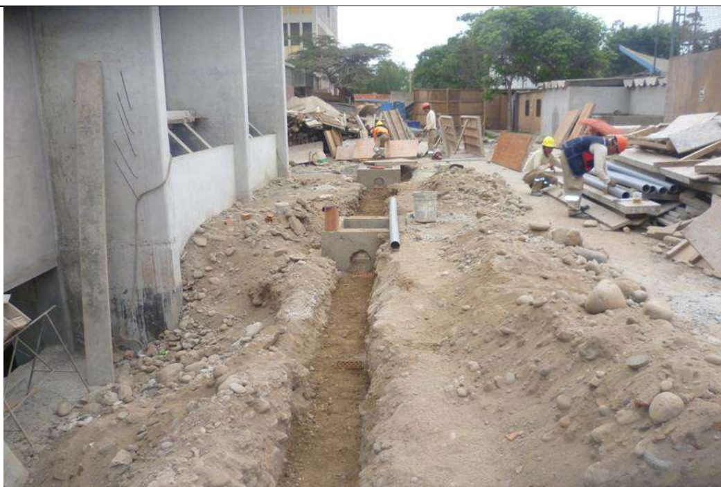
Instalación de agua y desagüe para la obra
