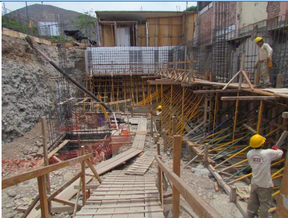
Construcción de muros de contención en sótano
