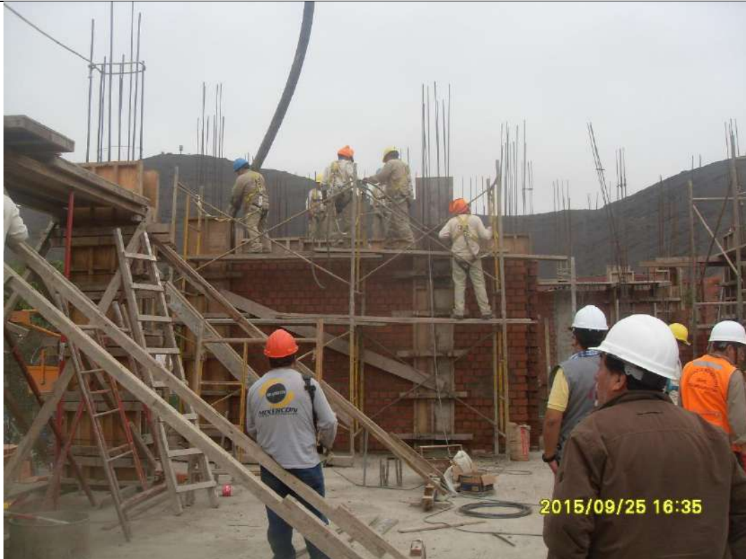
Revisión de vaciado de columnas por parte del Supervisor de la Obra. Ing. Javier Moreno Sotomayor
