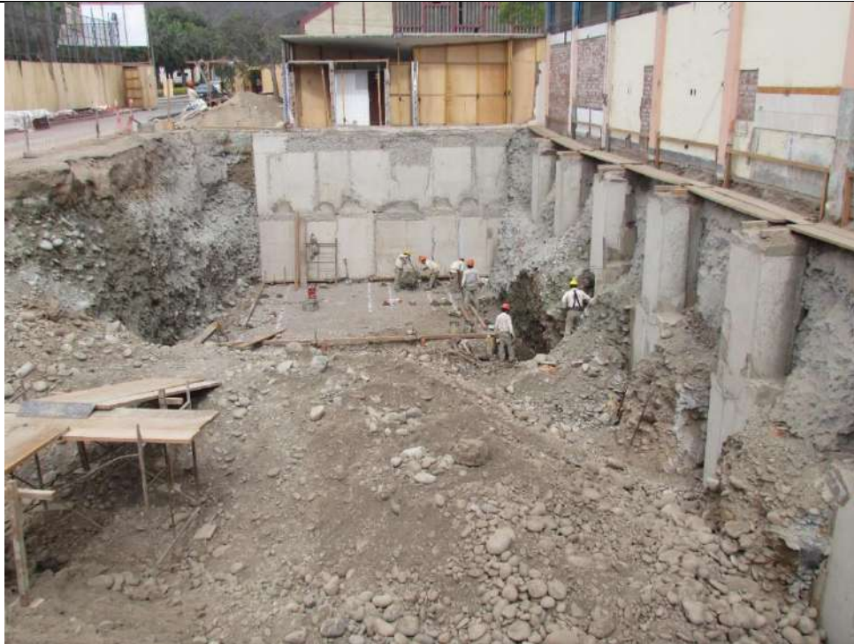
Construcción de calzaduras en el sótano
