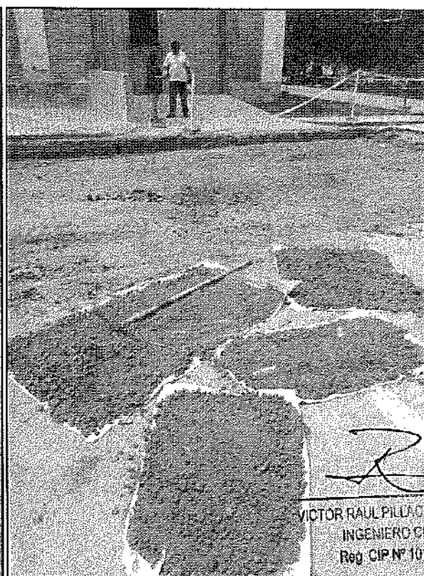
Foto N° 06: Demolición de pistas existente y La muestra de la sub rasante para el ensayo de Proctor
