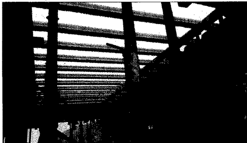
Foto N° 2: Colocado de viguetas prefabricadas.
