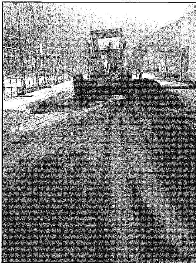
Foto N° 09: Conformación de la base 20 cm con afirmado
