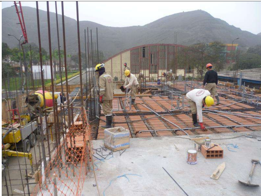
Llenado de concreto en losa aligerada del 1er nivel
