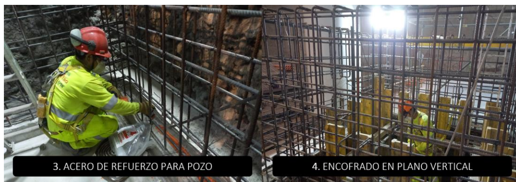
Figura N°81 Proceso constructivo de la partida pozo de bombeo (3-4). Fuente: Elaboración propia
