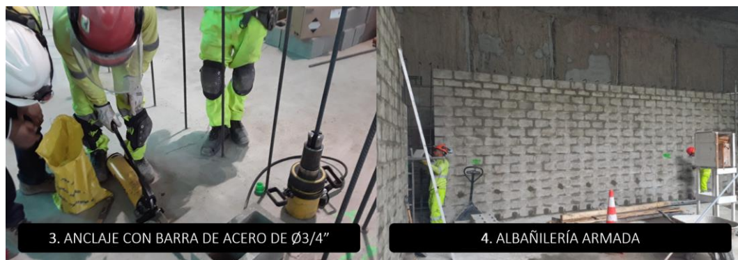
Figura N°105 Proceso constructivo de la partida albañilería (3-4). Fuente: Elaboración propia
