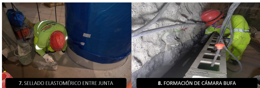
Figura N°69 Proceso constructivo de la partida losa de fondo (7-8). Fuente: Elaboración propia
