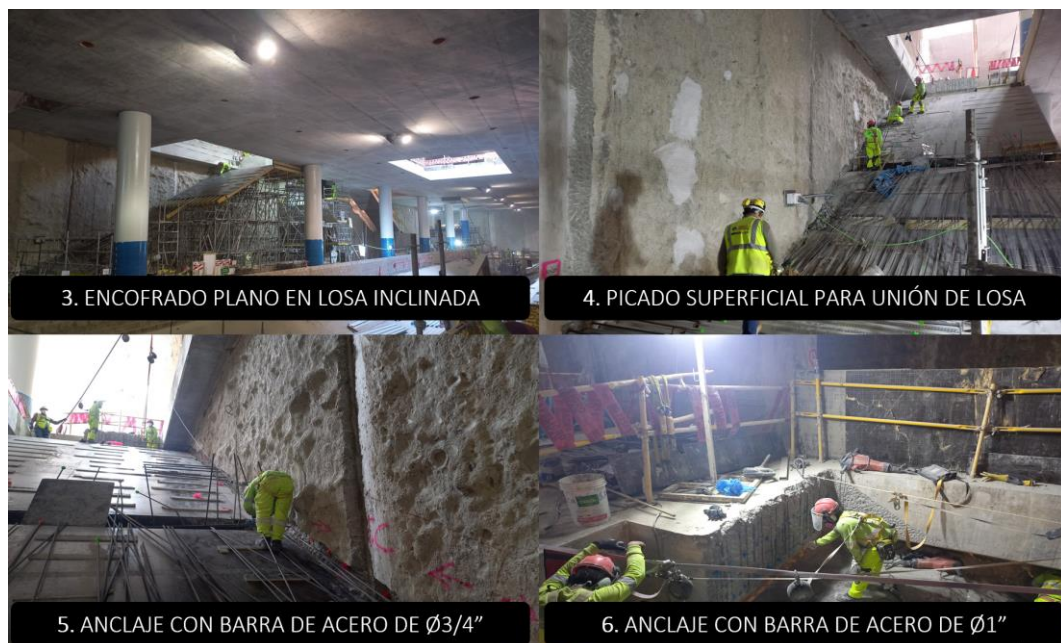
Figura N°92 Proceso constructivo de la partida escaleras (3-6). Fuente: Elaboración propia
