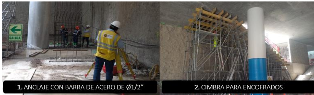
Figura N°91 Proceso constructivo de la partida escaleras (1-2). Fuente: Elaboración propia
