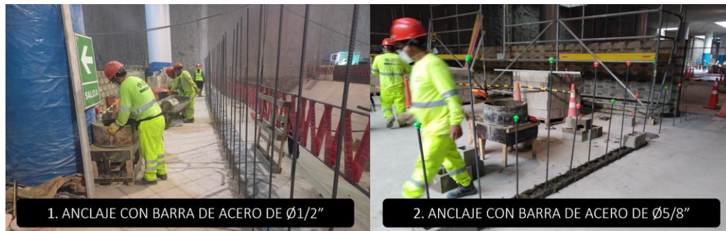
Figura N°104 Proceso constructivo de la partida albañilería (1-2). Fuente: Elaboración propia
