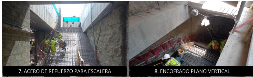
Figura N°93 Proceso constructivo de la partida escaleras (7-8). Fuente: Elaboración propia
