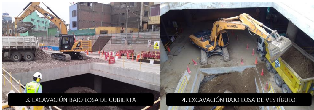
Figura N°42 Proceso constructivo de la partida movimiento de tierras (3-4). Fuente: Elaboración propia
