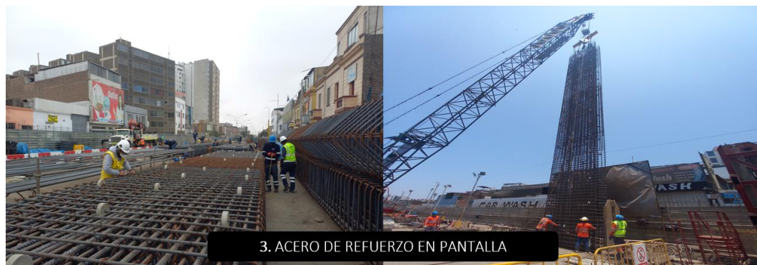
Figura N°48 Proceso constructivo de la partida muro pantalla (3). Fuente: Elaboración propia
