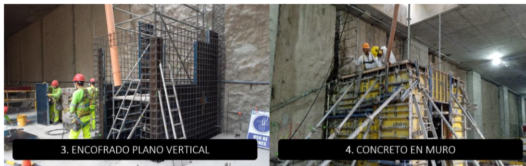
Figura N°110 Proceso constructivo de la partida albañilería (3-4). Fuente: Elaboración propia
