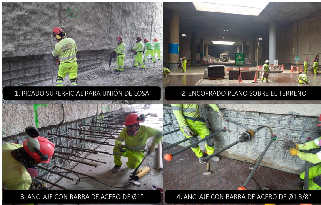
Figura N°61 Proceso constructivo de la partida losa de vestíbulo (1-4). Fuente: Elaboración propia
