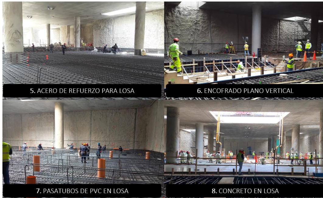
Figura N°62 Proceso constructivo de la partida losa de vestíbulo (5-8). Fuente: Elaboración propia
