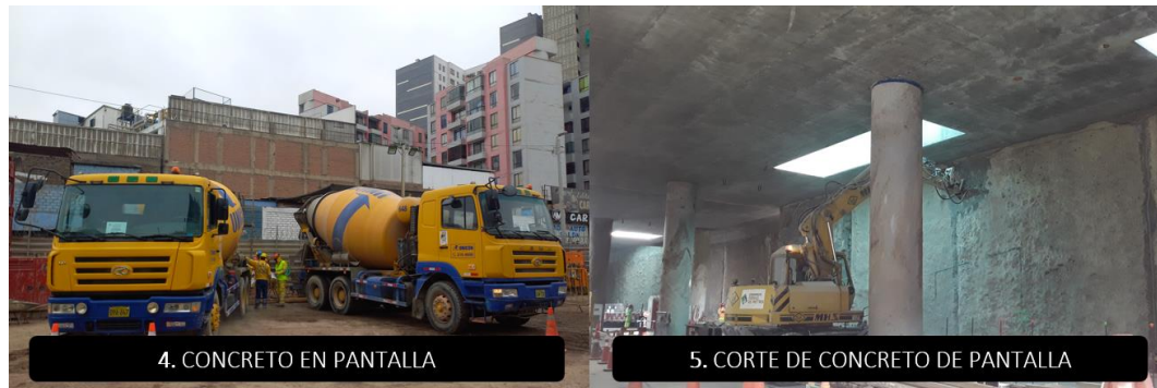
Figura N°49 Proceso constructivo de la partida muro pantalla (4-5). Fuente: Elaboración propia
