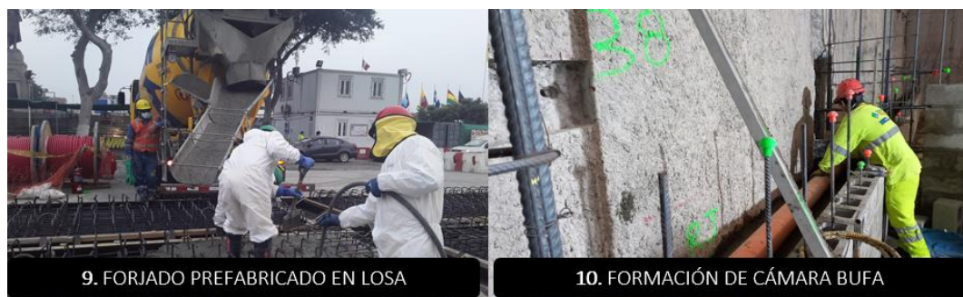
Figura N°63 Proceso constructivo de la partida losa de vestíbulo (9-10). Fuente: Elaboración propia
