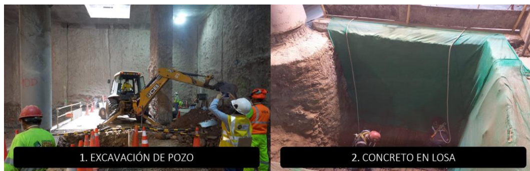
Figura N°80 Proceso constructivo de la partida pozo de bombeo (1-2). Fuente: Elaboración propia
