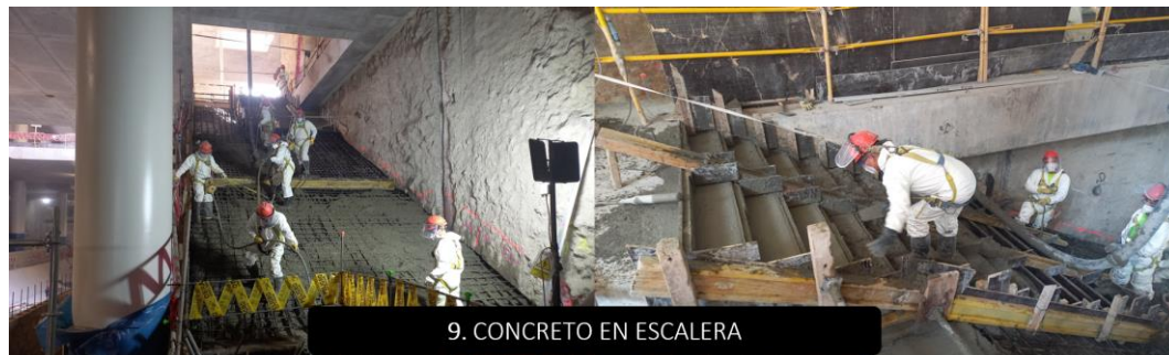
Figura N°94 Proceso constructivo de la partida escaleras (9). Fuente: Elaboración propia
