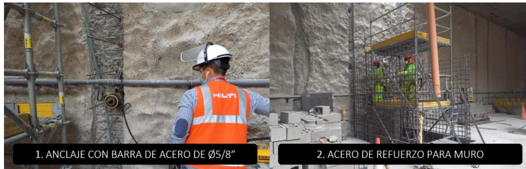
Figura N°109 Proceso constructivo de la partida ascensores (1-2). Fuente: Elaboración propia
