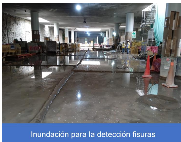
Figura N°127 Inundación de losa para la detección de fisuras en losa.
