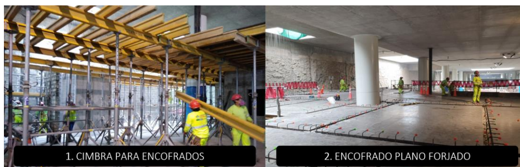
Figura N°114 Proceso constructivo de la partida losa de prevestíbulo (1-2). Fuente: Elaboración propia
