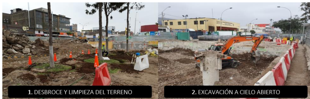
Figura N°41 Proceso constructivo de la partida movimiento de tierras (1-2). Fuente: Elaboración propia
