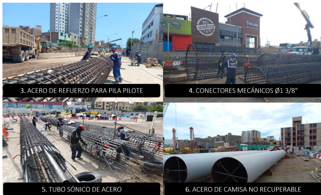
Figura N°74 Proceso constructivo de la partida pila pilote (3-6). Fuente: Elaboración propia
