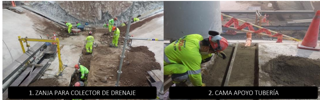
Figura N°86 Proceso constructivo de la partida drenaje bajo losa (1-2). Fuente: Elaboración propia
