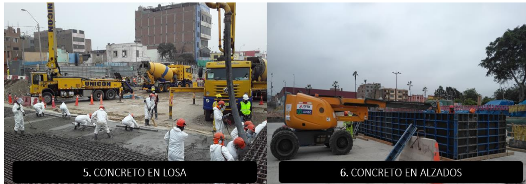
Figura N°56 Proceso constructivo de la partida losa de cubierta (5-6). Fuente: Elaboración propia
