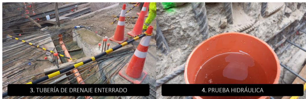
Figura N°87 Proceso constructivo de la partida drenaje bajo losa (3-4). Fuente: Elaboración propia
