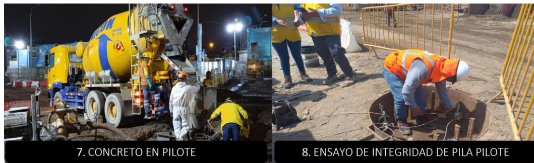
Figura N°75 Proceso constructivo de la partida pila pilote (7-8). Fuente: Elaboración propia
