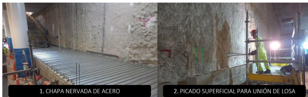
Figura N°98 Proceso constructivo de la partida losa de andén (1-2). Fuente: Elaboración propia
