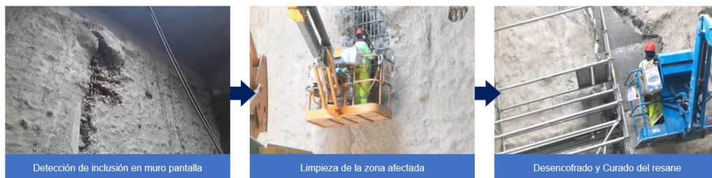
Figura N°125 Proceso de resane por contaminación en muros pantalla. Fuente: Elaboración propia
