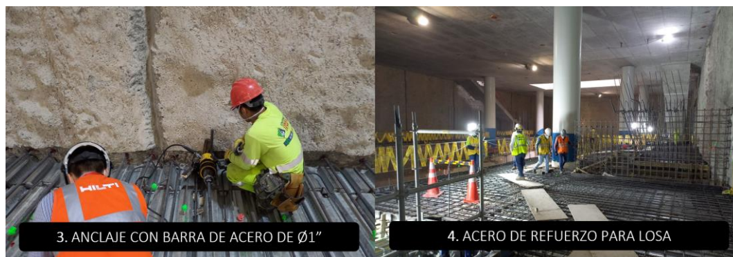
Figura N°99 Proceso constructivo de la partida losa de andén (3-4). Fuente: Elaboración propia
