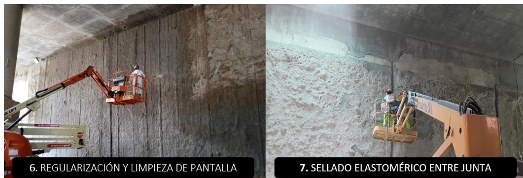
Figura N°50 Proceso constructivo de la partida muro pantalla (6-7). Fuente: Elaboración propia
