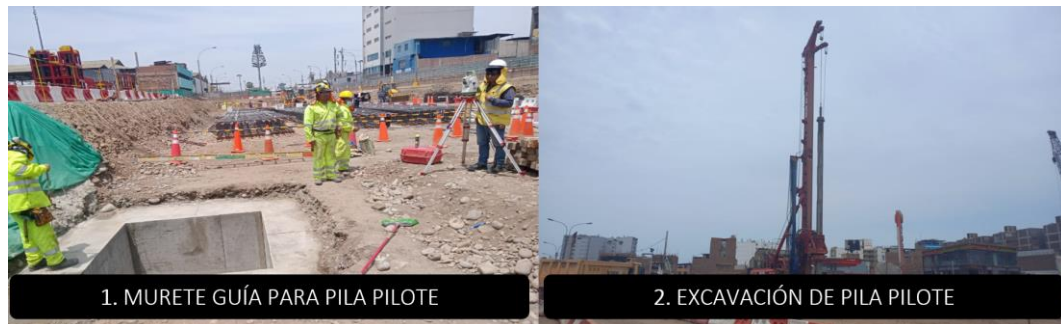
Figura N°73 Proceso constructivo de la partida pila pilote (1-2). Fuente: Elaboración propia
