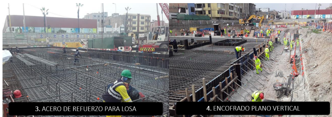
Figura N°55 Proceso constructivo de la partida losa de cubierta (3-4). Fuente: Elaboración propia
