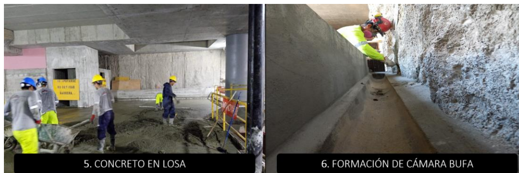
Figura N°116 Proceso constructivo de la partida losa de prevestíbulo (5-6). Fuente: Elaboración propia
