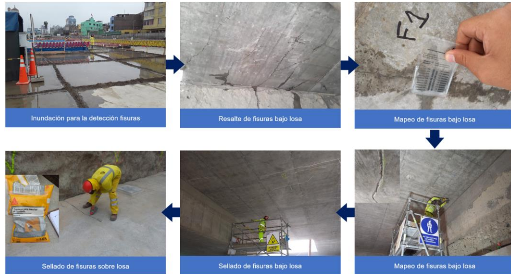
Figura N°126 Proceso de resane de fisuras en losa de cubierta. Fuente: Elaboración propia
