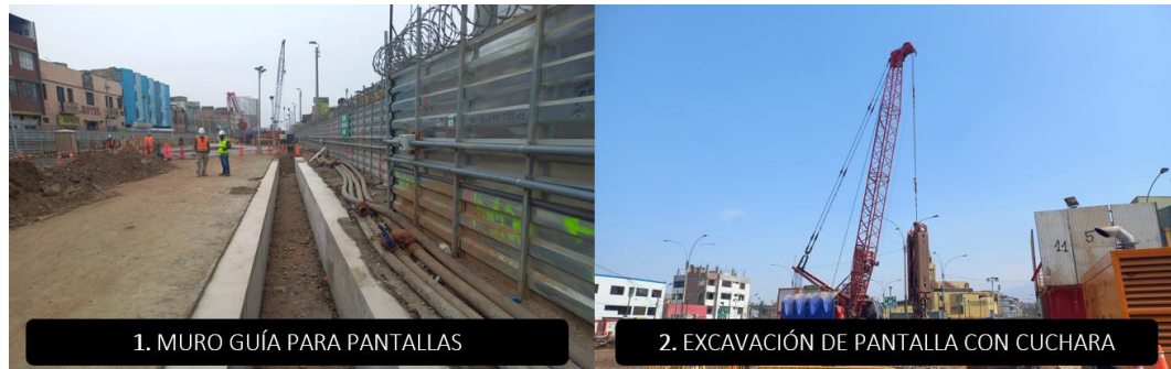
Figura N°47 Proceso constructivo de la partida muro pantalla (1-2). Fuente: Elaboración propia
