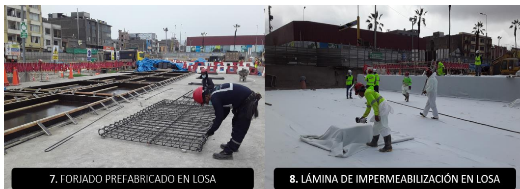
Figura N°57 Proceso constructivo de la partida losa de cubierta (7-8). Fuente: Elaboración propia
