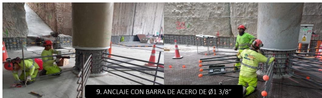
Figura N°76 Proceso constructivo de la partida pila pilote (9). Fuente: Elaboración propia
