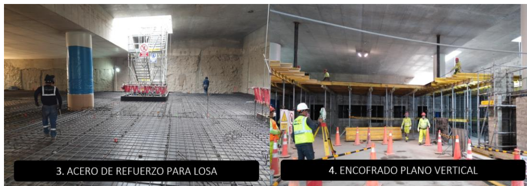
Figura N°115 Proceso constructivo de la partida losa de prevestíbulo (3-4). Fuente: Elaboración propia
