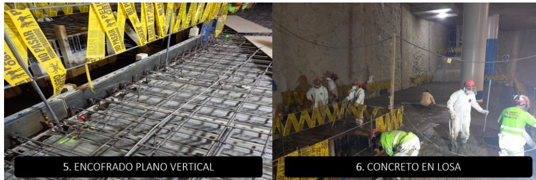
Figura N°100 Proceso constructivo de la partida losa de andén (5-6). Fuente: Elaboración propia
