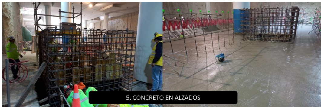
Figura N°82 Proceso constructivo de la partida pozo de bombeo (5). Fuente: Elaboración propia
