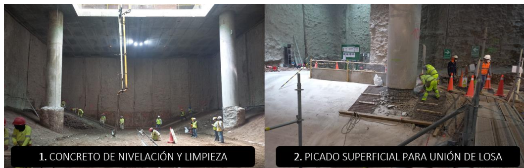
Figura N°67 Proceso constructivo de la partida losa de fondo (1-2). Fuente: Elaboración propia
