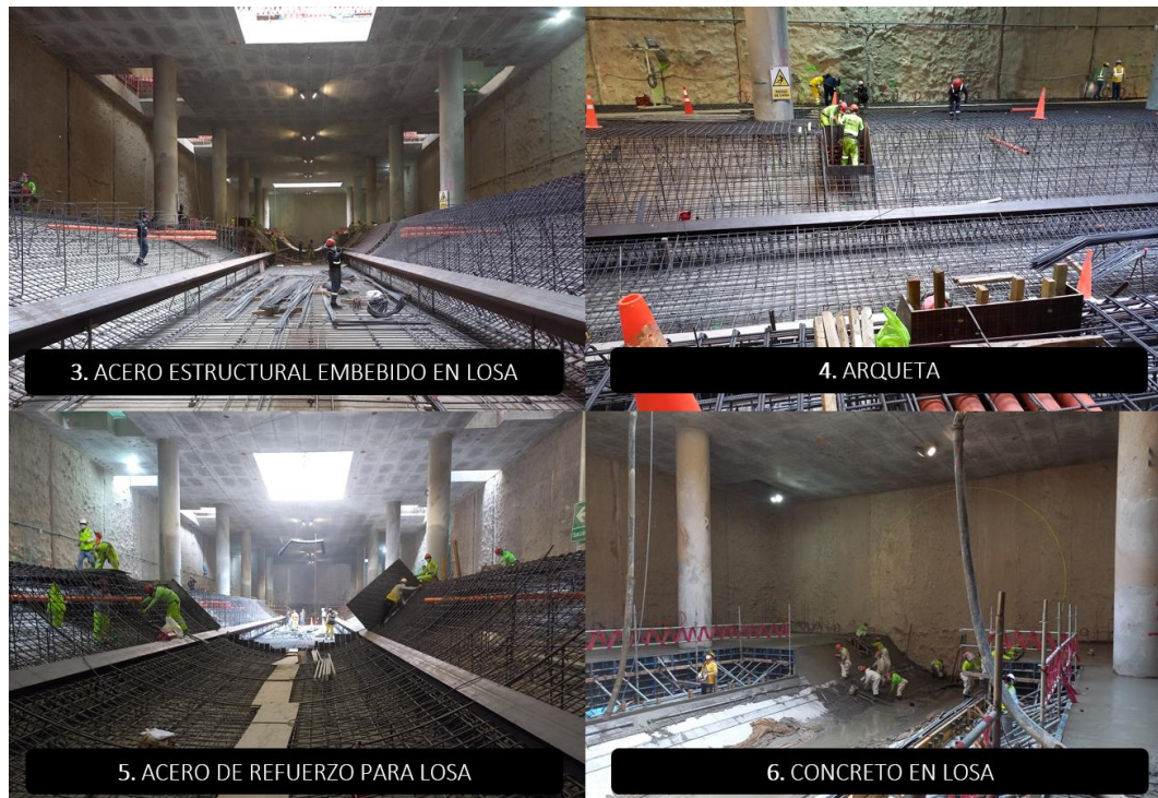
Figura N°68 Proceso constructivo de la partida losa de fondo (3-6). Fuente: Elaboración propia
