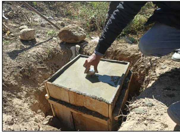
Figura N°3.7: Encofrado y vaciado de concreto
