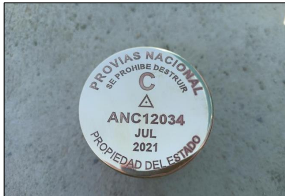
Figura N°3.8: Placa de cobre empotrada
