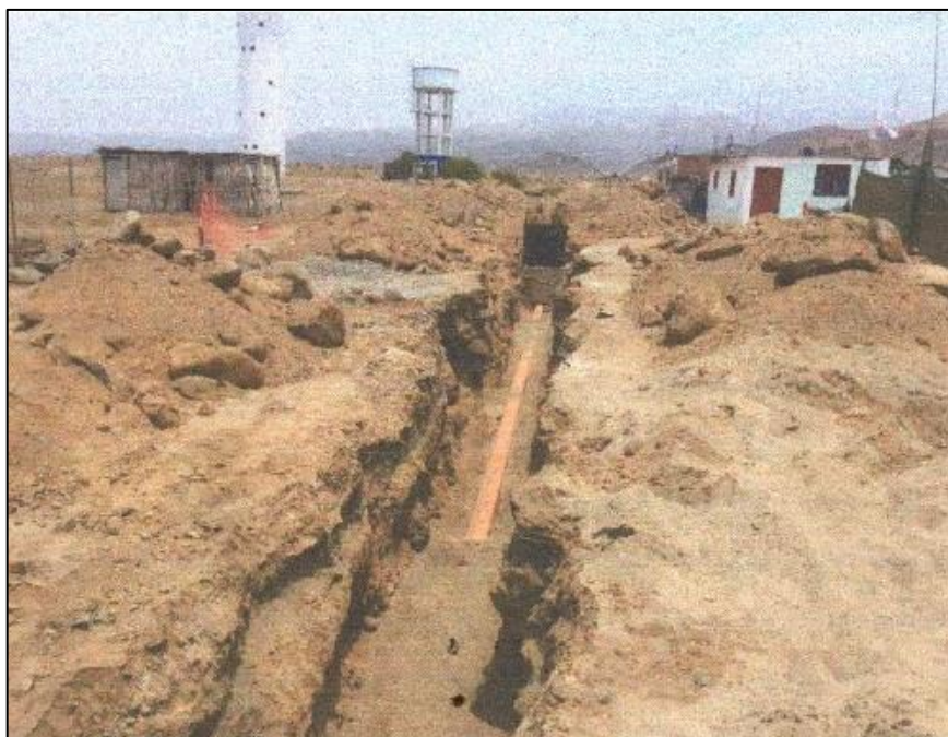
Figura N° 3.18. Tubería cubierta parcialmente con arena gruesa.
