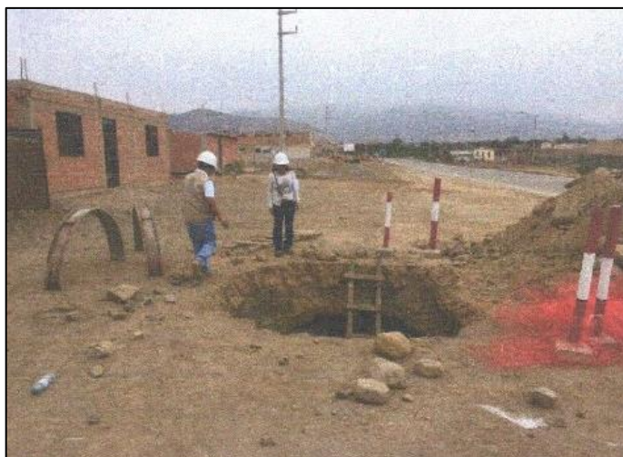
Figura N° 3.12. Cerco de malla de HDP 1 m.
