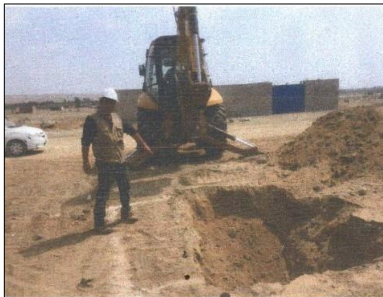
Figura N° 3.10. Trazo y replanteo de un buzón siendo supervisado.
