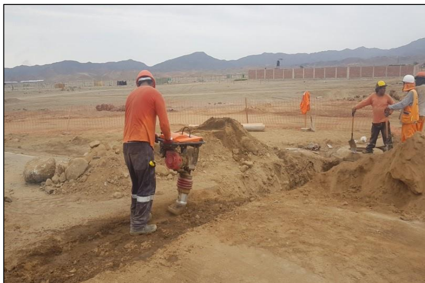
Figura N° 3.19. Apisonador utilizado en la compactación del segundo relleno de la tubería.
