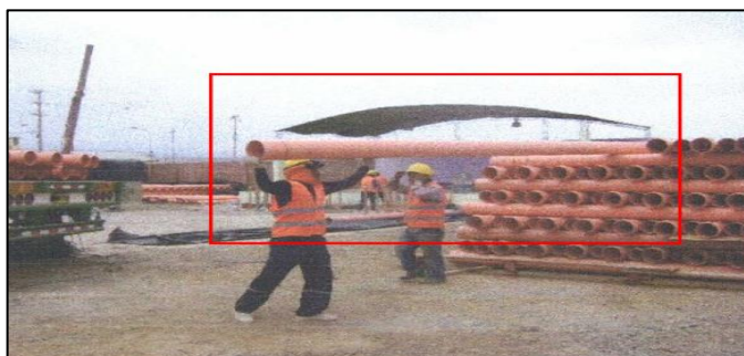
Figura N° 3.5. Campamento provisional de la obra.
