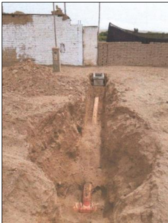
Figura N° 3.30. Excavación del suministro de tuberías para conexiones domiciliarias hasta la caja de registro.
