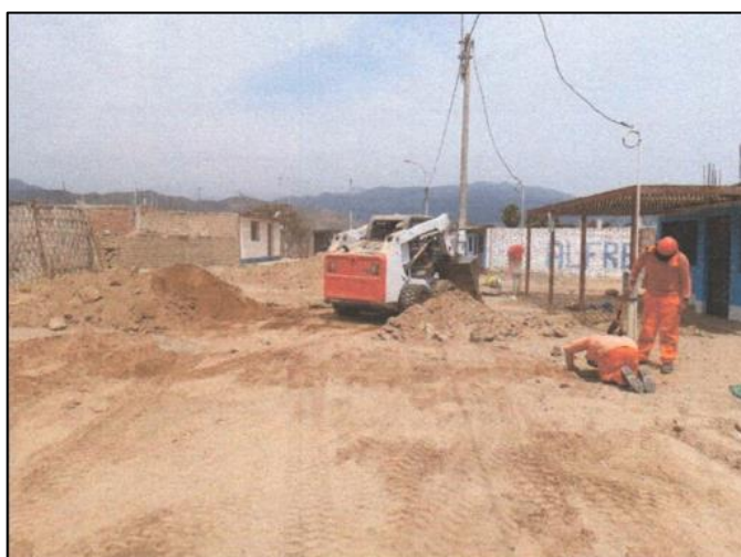
Figura N° 3.32. Relleno de zanja compactado con la maquinaria Bobcat.
