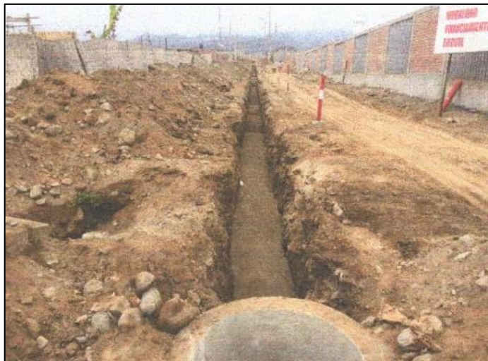
Figura N° 3.17. Colocación de la cama de arena sobre todo el eje de tubería.
