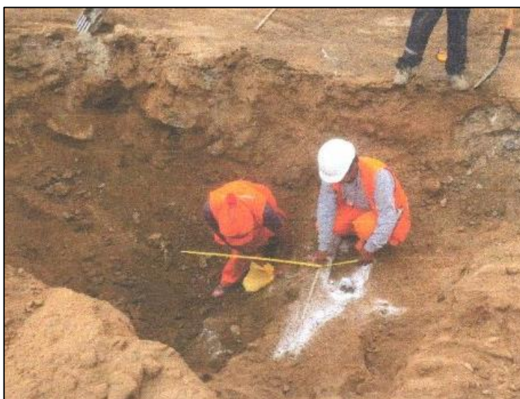
Figura N° 3.9. Replanteo de buzones a través del BM.
