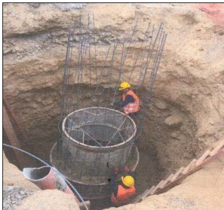
Figura N° 3.25. Buzón Tipo B de concreto armado.
