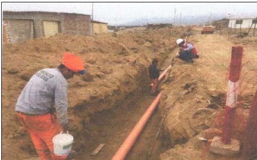
Figura N° 3.21. Colocación e instalación de tuberías de alcantarillado.
