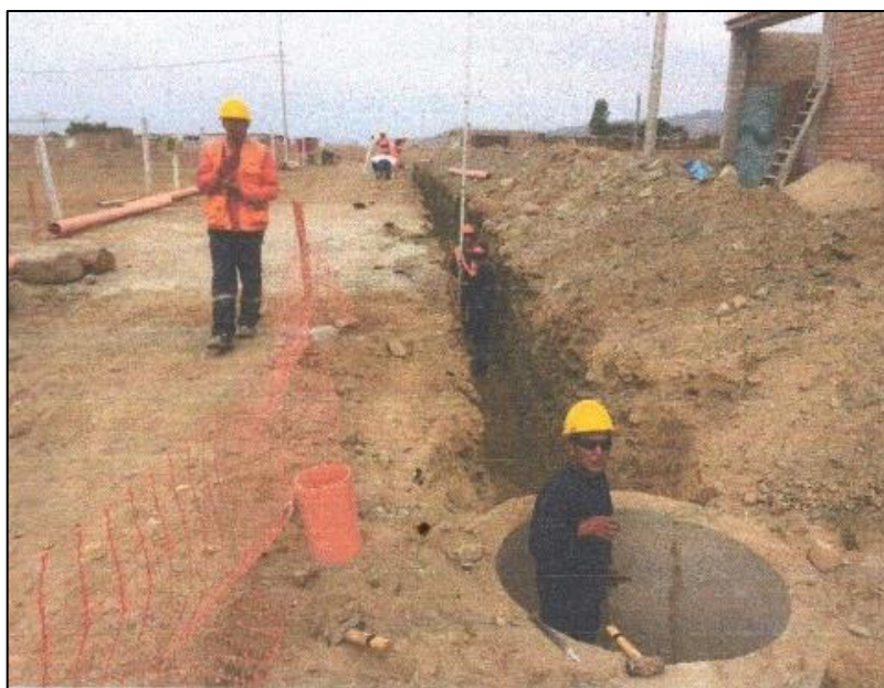
Figura N° 3.16. Nivelación para la colocación de la cama de arena.
