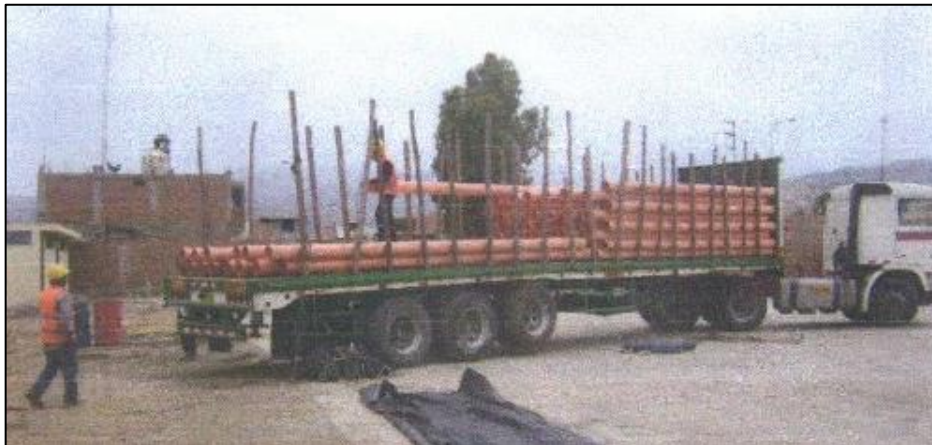
Figura N° 3.8. Traslado de tuberías hacia el almacén de obra.
