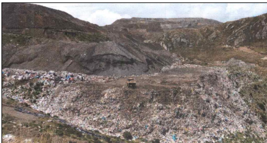
Figura 3.4: Talud inestable del Botadero de Rumiallana, 2021
