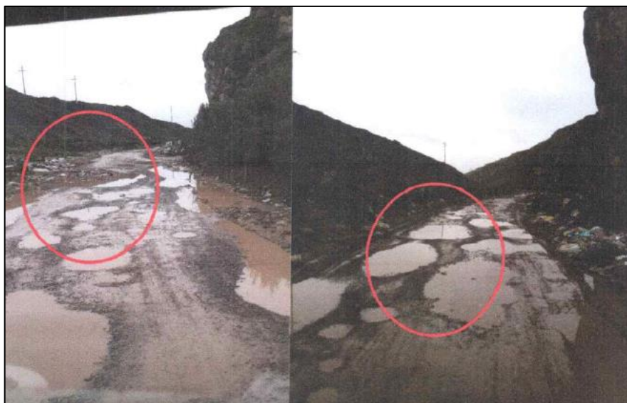
Figura 7.5: Presencia de hoyos y desechos sólidos que obstaculizan la ruta del camión compactador
