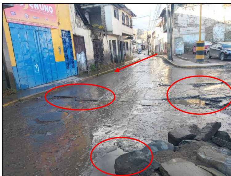
Figura A7. 2: Vías demasiadas antiguas con roturas y grietas en sus tramos, Jr. Lima, junio 2022
