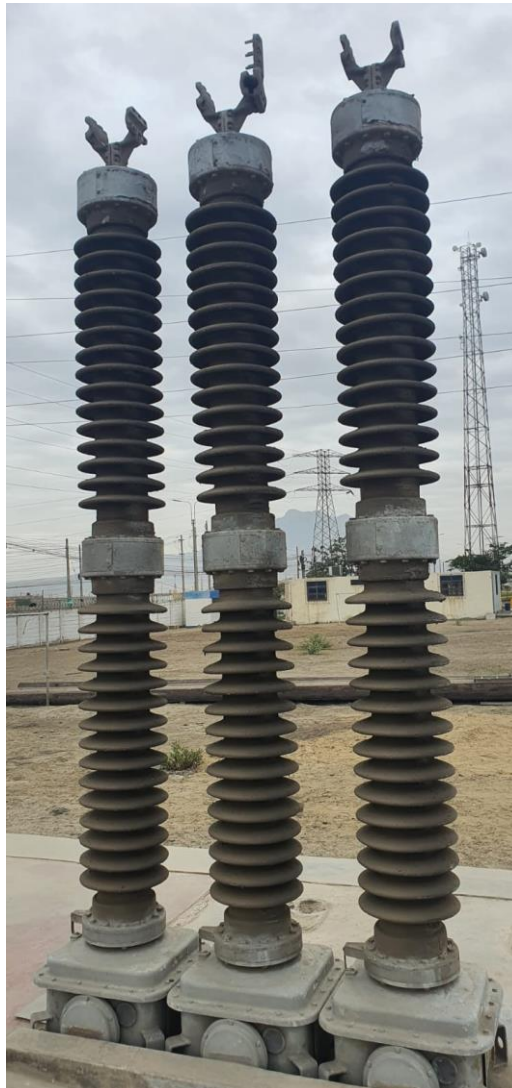
Figura 2.6: Transformador de tensión.
