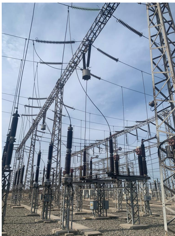
Figura 3.21: Foto posterior al cambio del TT explotado.
