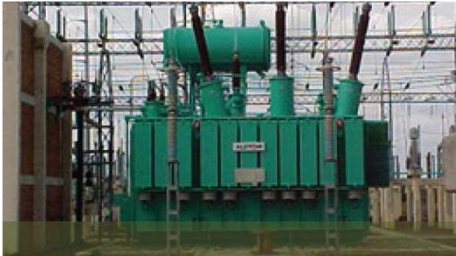
Figura 2.3: Subestación Eléctrica reductora
