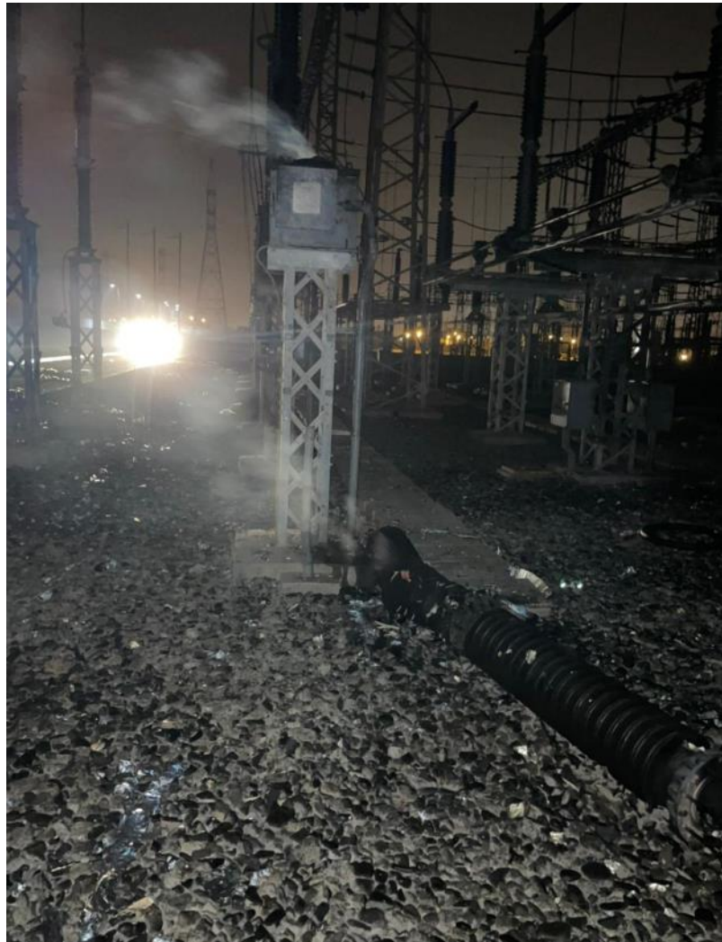
Figura 3.8: Transformador TT-356, fase "R" después de la explosión.
