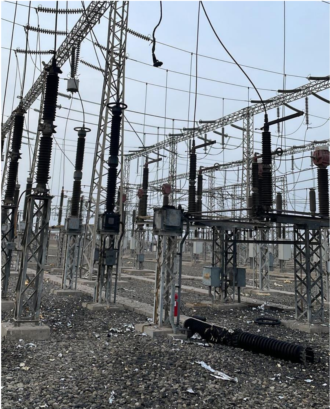
Figura 3.9: Estado general de la celda perteneciente al transformador TT-356 posterior a la explosión
