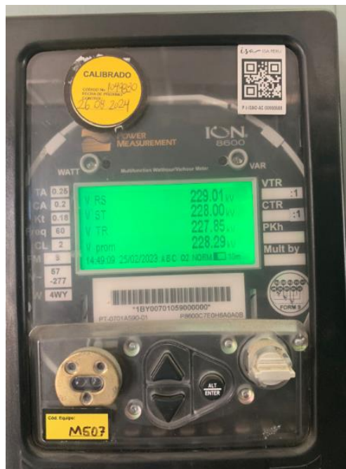
Figura 3.14: Medidor de marca ION usado en transmisión
