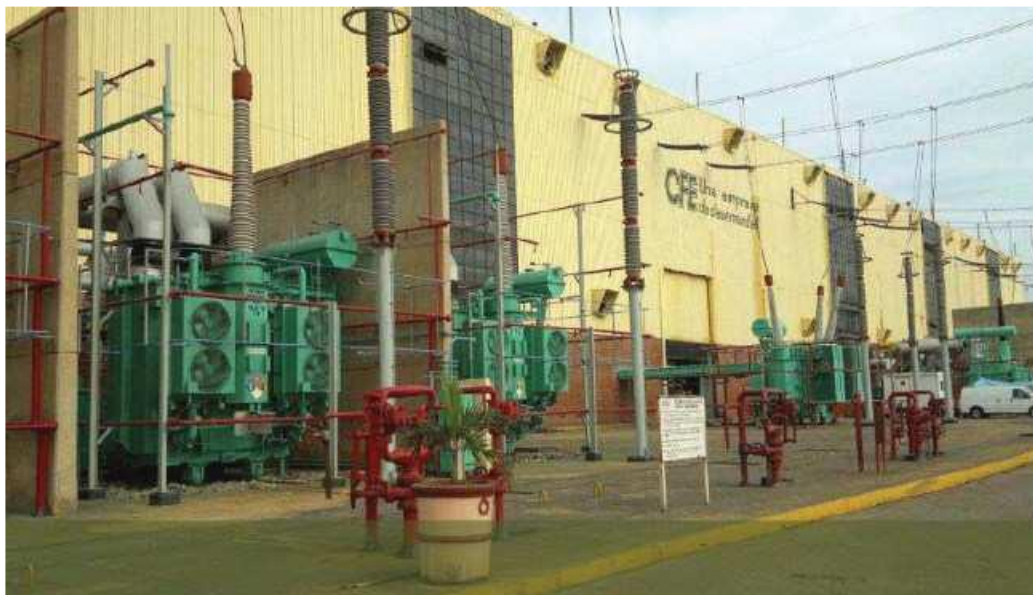
Figura 2.2: Subestación Eléctrica elevadora
