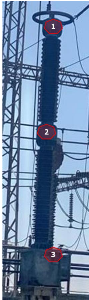
Figura 4.8: Identificación de las partes de donde se extrajeron las muestras de aceite.
