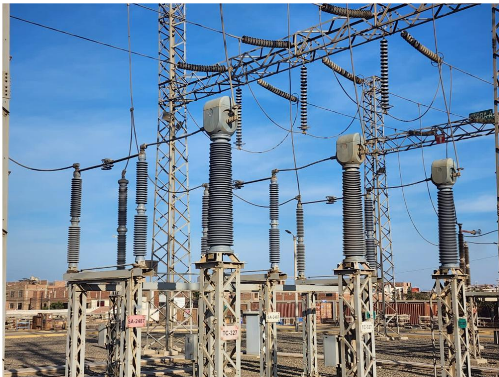
Figura 2.8: Transformador de corriente
