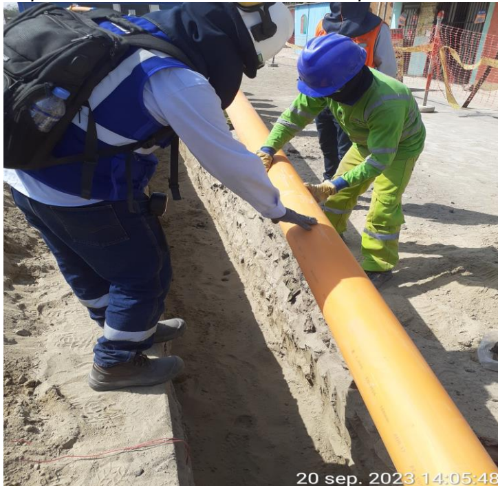
Figura 27 Inspección visual a la tubería matriz de polietileno
