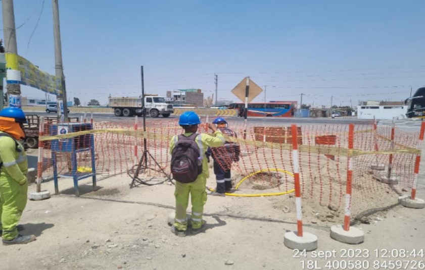
Figura 42 Proceso de venteo de gas natural
