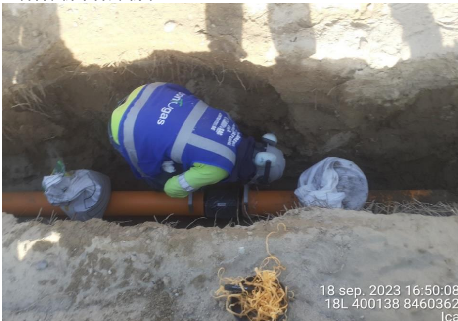
Figura 15 Proceso de electrofusión
