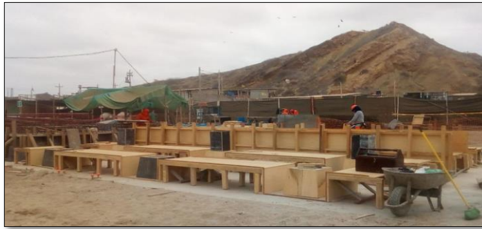
Imagen 48. Encofrado normal de vigas prefabricadas.
