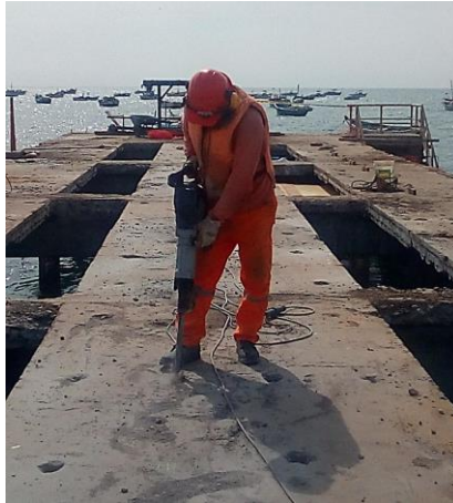
Imagen 29. Perforación de abertura en losa para pasar los elementos tensores
