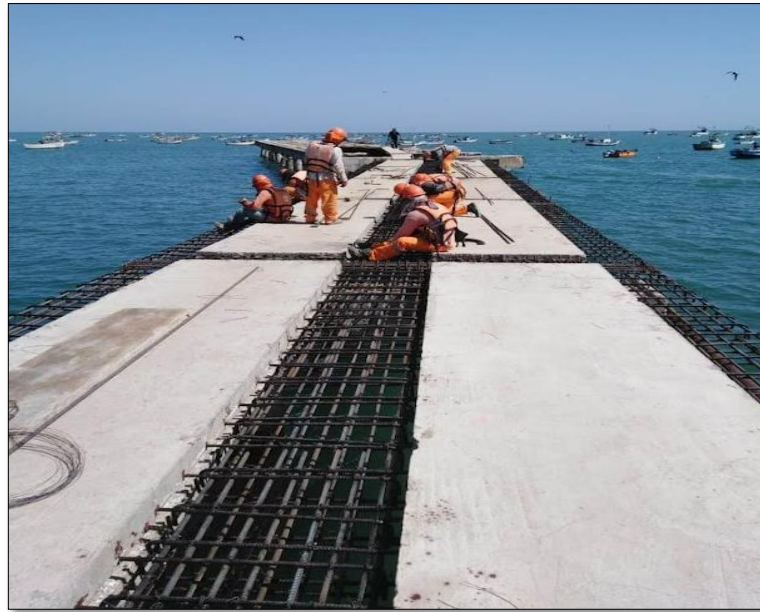
Imagen 57. Armado de acero in situ en losas y vigas en puente de muelle
