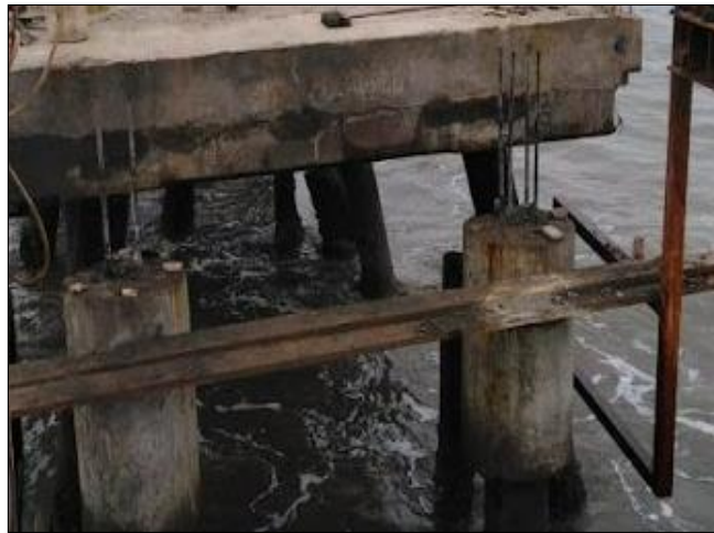
Imagen 52. Muestra de las “mechas” de acero corrugado
