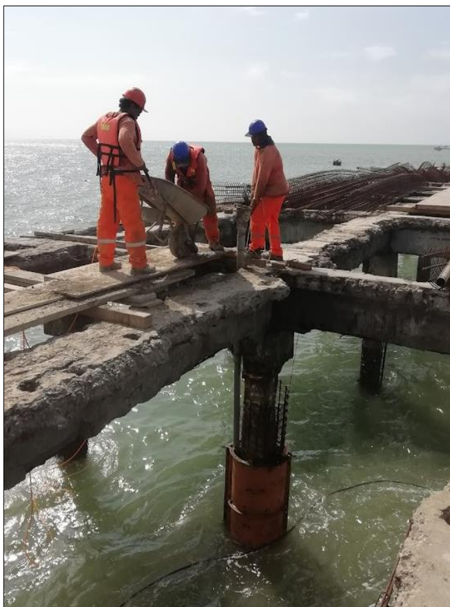
Imagen 42. Vaciado de concreto aplicando el método Tremie
