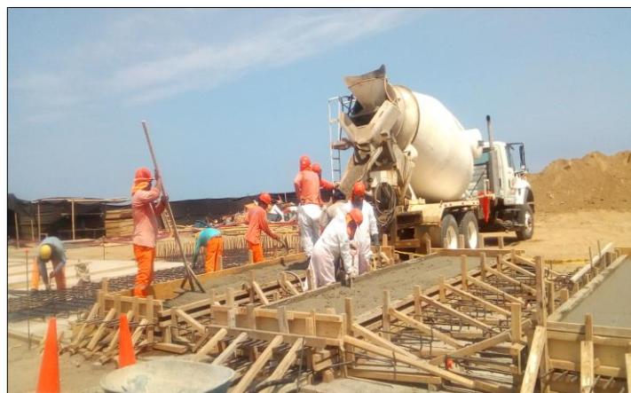
Imagen 50. Vaciado de concreto de losa prefabricada
