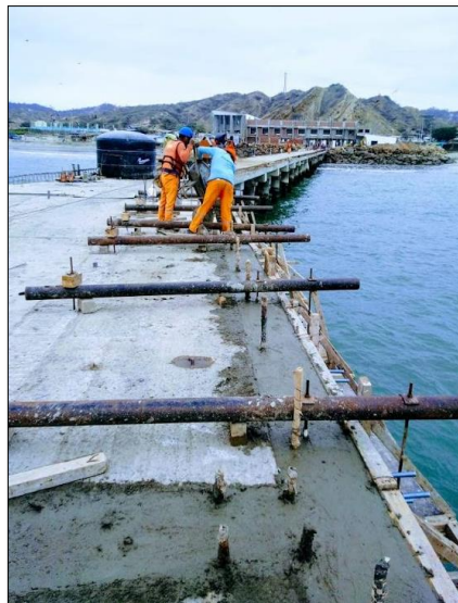
Imagen 60. Encofrado y vaciado de concreto en borde de plataforma
