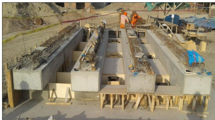
Imagen 49. Muestra final de encofrado
