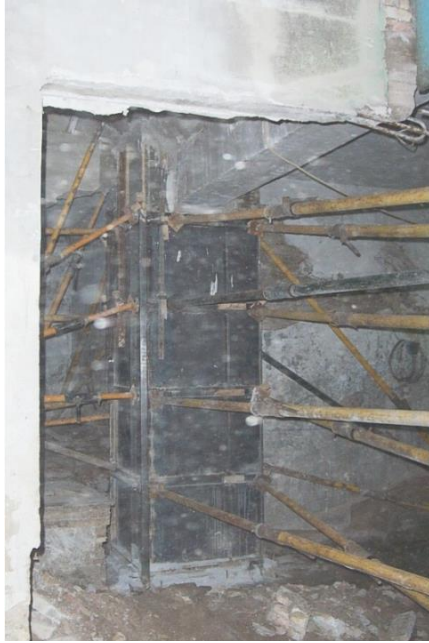
Imagen 12. Encofrado de columna a reforzar
