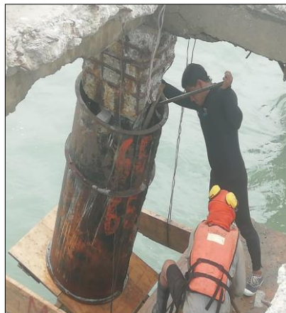
Imagen 41. Encofrado de pilote con moldes metálicos
