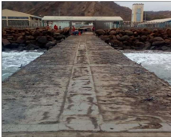
Imagen 18. Deterioro de superficie de la plataforma del muelle
