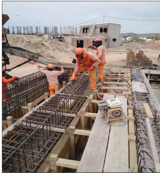
Imagen 51. Vaciado de concreto de vigas prefabricadas
