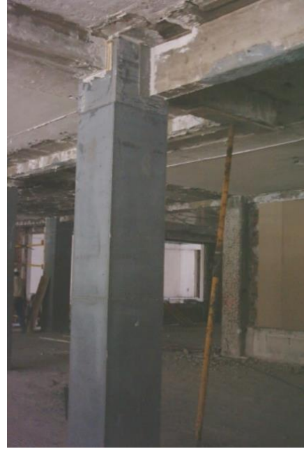
Imagen 13. Superficie de la columna posterior al desencofrado
