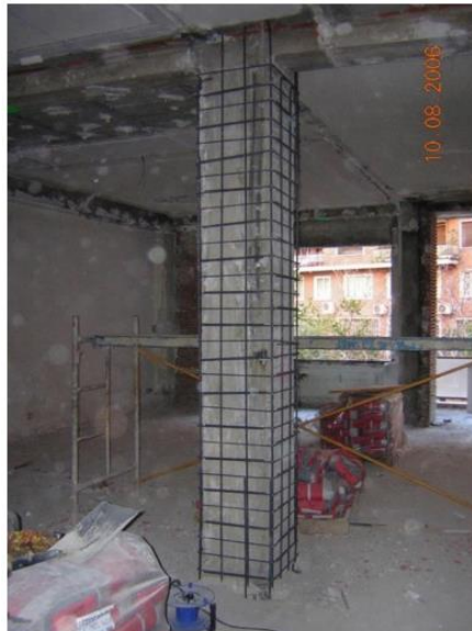
Imagen 11. Refuerzo de acero en columna
