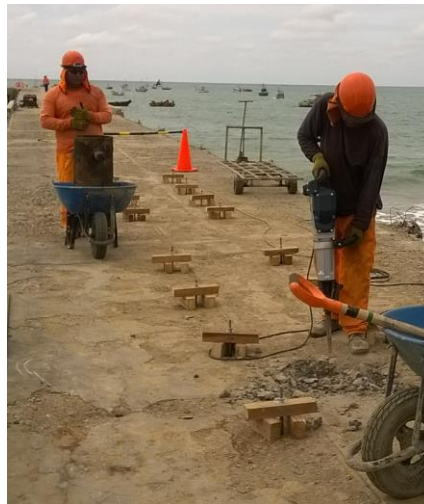
Imagen 30. Uso de barras roscadas como elemento tensor
