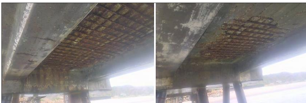
Imagen 19. Exposición de acero en estado de corrosión
