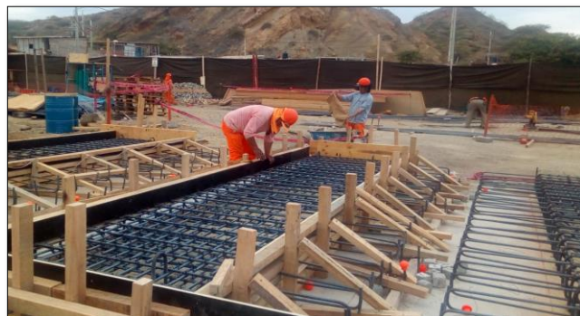
Imagen 47. Encofrado normal de losa prefabricada
