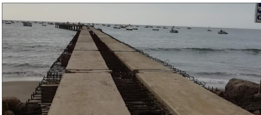
Imagen 56. Instalación de losas prefabricadas en el puente
