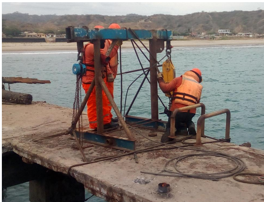
Imagen 25. Caballete para extracción de rieles metálicas
