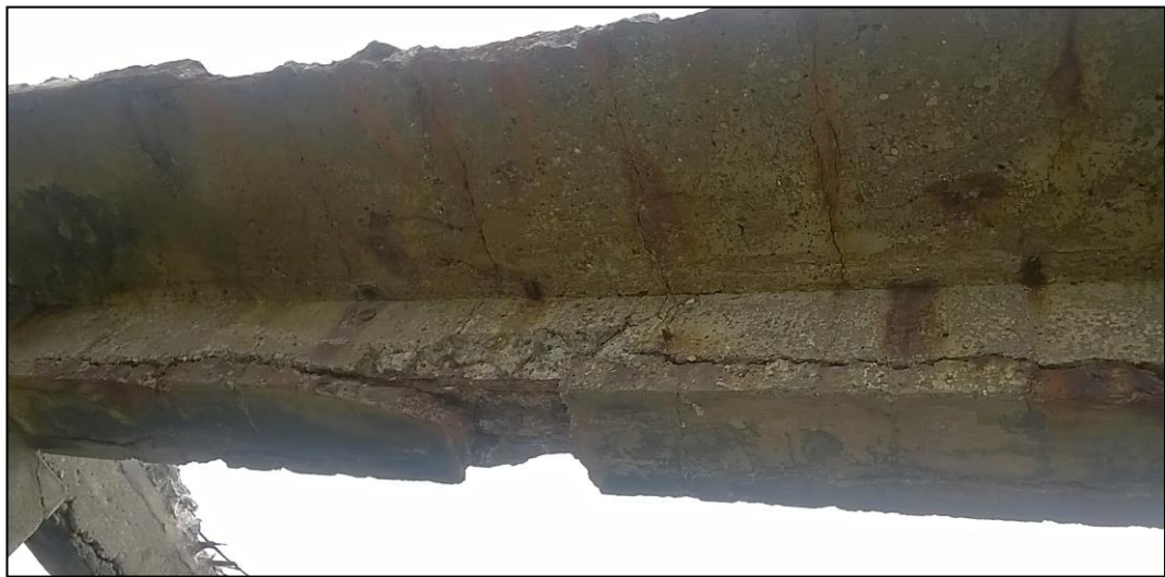
Imagen 20. Grietas, desprendimiento de concreto y exposición de acero en vigas
