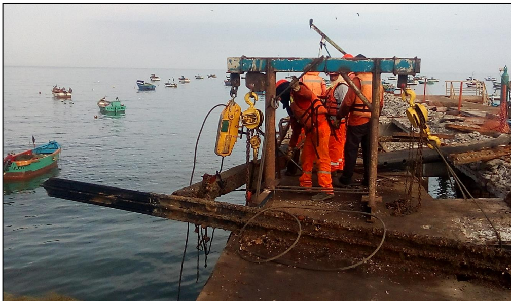
Imagen 27. Extracción de riel metálico con el uso de caballete, tirfor y tecele manual
