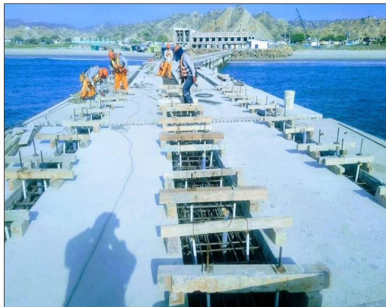
Imagen 58. Encofrado colgante, posterior al armado de acero de refuerzo
