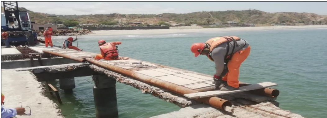
Imagen 35. Plataforma provisional para fijar estructura losa – viga para desmontarla.
