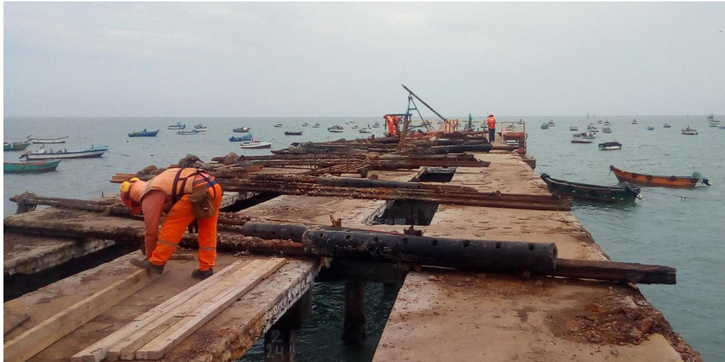
Imagen 28. Rieles metálicos extraídas de la defensa de riel metálico
