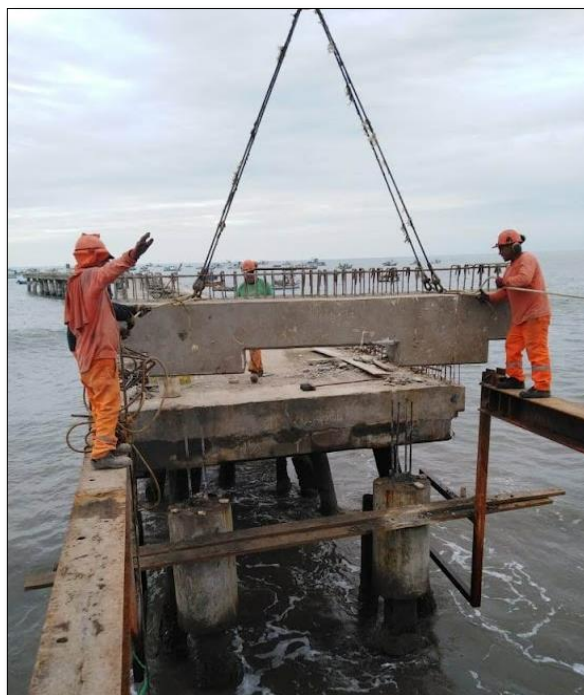
Imagen 53. Colocación de viga prefabricada, alineada a las “mechas” de acero corrugado de los pilotes
