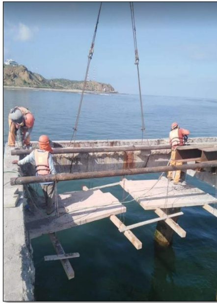
Imagen 36. Plataforma móvil para escombros para evitar contaminación en el mar
