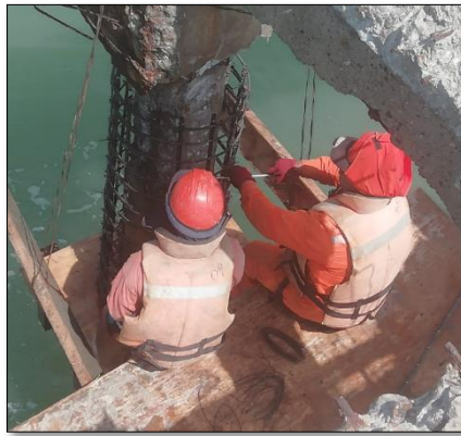
Imagen 40. Refuerzo con armadura de acero corrugado en pilote
