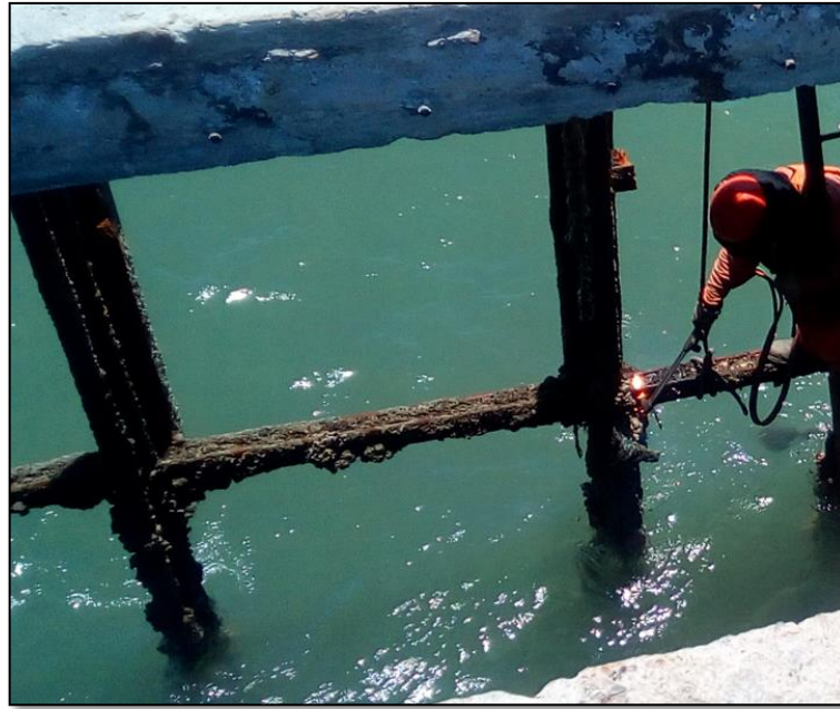
Imagen 26. Corte con equipo de oxicorte de riel horizontal del sistema de defensa del muelle
