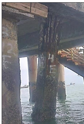
Imagen 22. Desprendimiento de concreto con exposición del acero de refuerzo en proceso de corrosión
