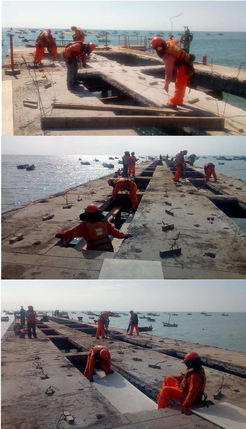
Imagen 31. Secuencia de instalación de la infraestructura del encofrado colgante
