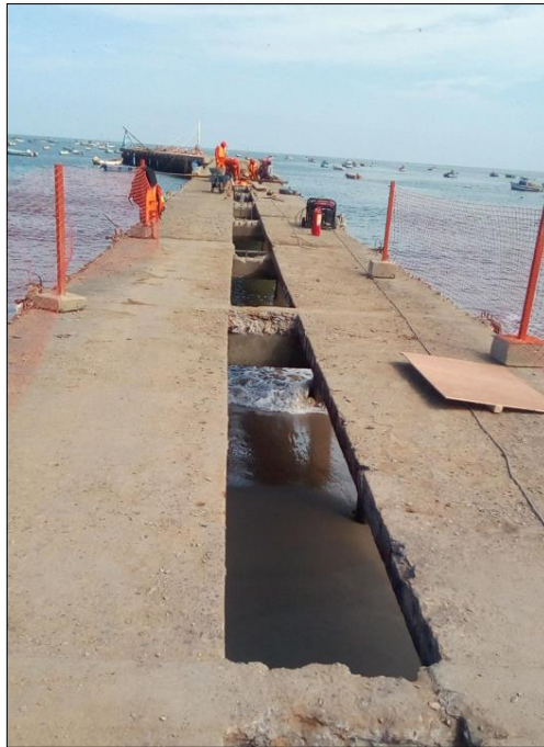
Imagen 33. Demolición de paños centrales en puente de muelle
