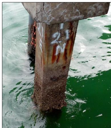
Imagen 17. Presencia de grietas y oxidación en Pilote 1 Sur Eje 2
