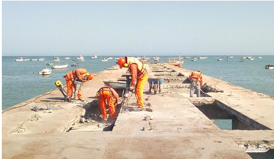
Imagen 32. Demolición de tramo de losa en el cabezo del muelle
