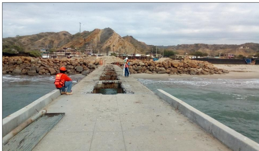
Imagen 45. Parte superior de las losas de los tramos 8-9 con vista al acero al descubierto
