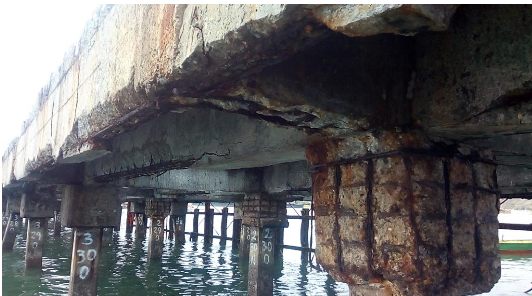
Imagen 23. Desprendimiento de recubrimiento de concreto en vigas del cabezo del muelle
