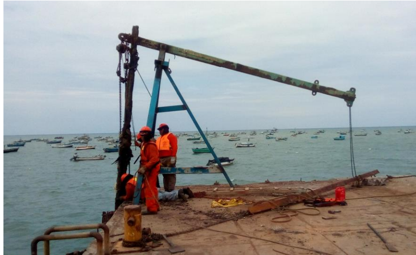
Imagen 24. Estructura para extracción de rieles inicial.
