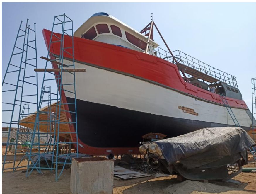
Figura 3.1: Construcción de embarcación de madera de 100 toneladas destinada a la pesca industrial de anchoveta.
