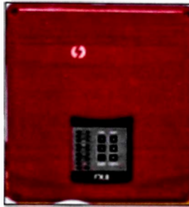
Imagen 105. Panel de detección y alarma contra incendios.
