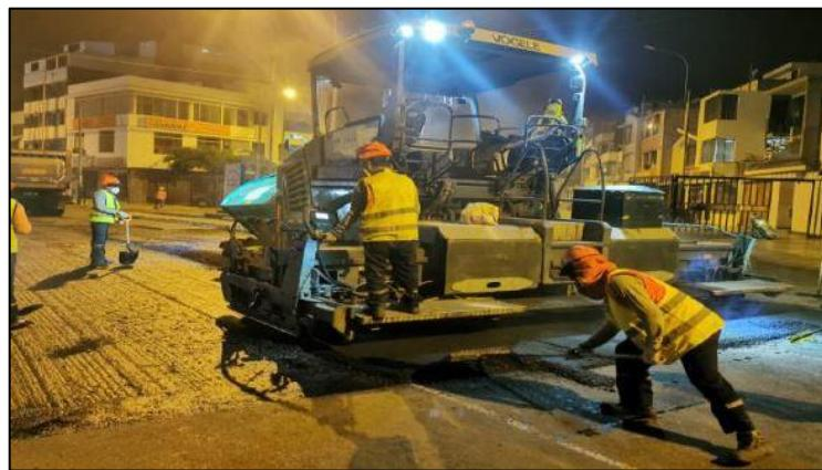
Una vez colocada la mezcla asfáltica sobre la superficie, se realiza la medición del espesor mediante un punzón calibrado, considerando un 25% de esponjamiento de la mezcla. Para este proceso, el Contratista debe disponer la presencia permanente de su Especialista en Suelos y Pavimentos, a fin de asegurar la calidad y la adecuada ejecución de los trabajos.
