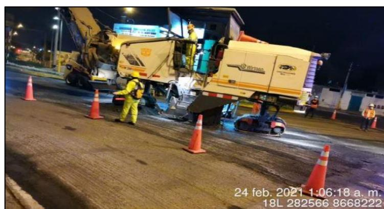
Producto del fresado, se debe contar con una superficie uniforme en todo el sector, verificando la profundidad o espesor del corte, el cual debe ser aproximado a 2" según lo requerido en Término de Referencia. Menores o mayores espesores deben ser sustentados por el Contratista y autorizados por el Supervisor del Servicio.
