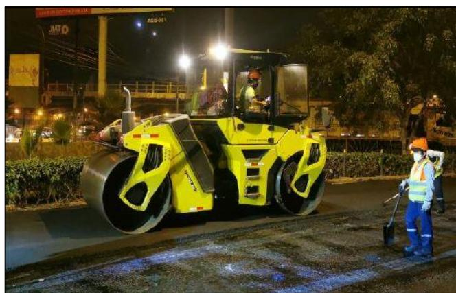
Luego de la compactación del rodillo liso con vibración, se continua con la compactación de la carpeta mediante rodillos de neumáticos, donde se debe
