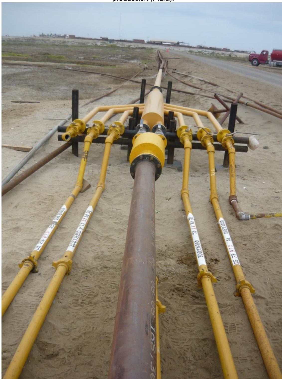
Foto 6. Sistema de transporte de petróleo y gas desde los pozos hacia baterías de producción (Piura).
