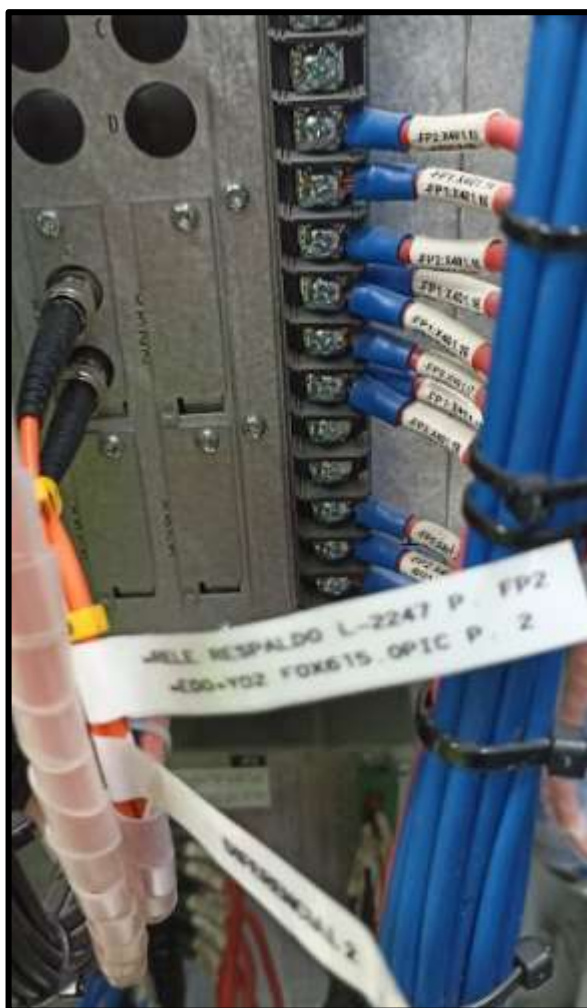
Nota: conexión de fibra multimodo conector ST en el lado del relé.
