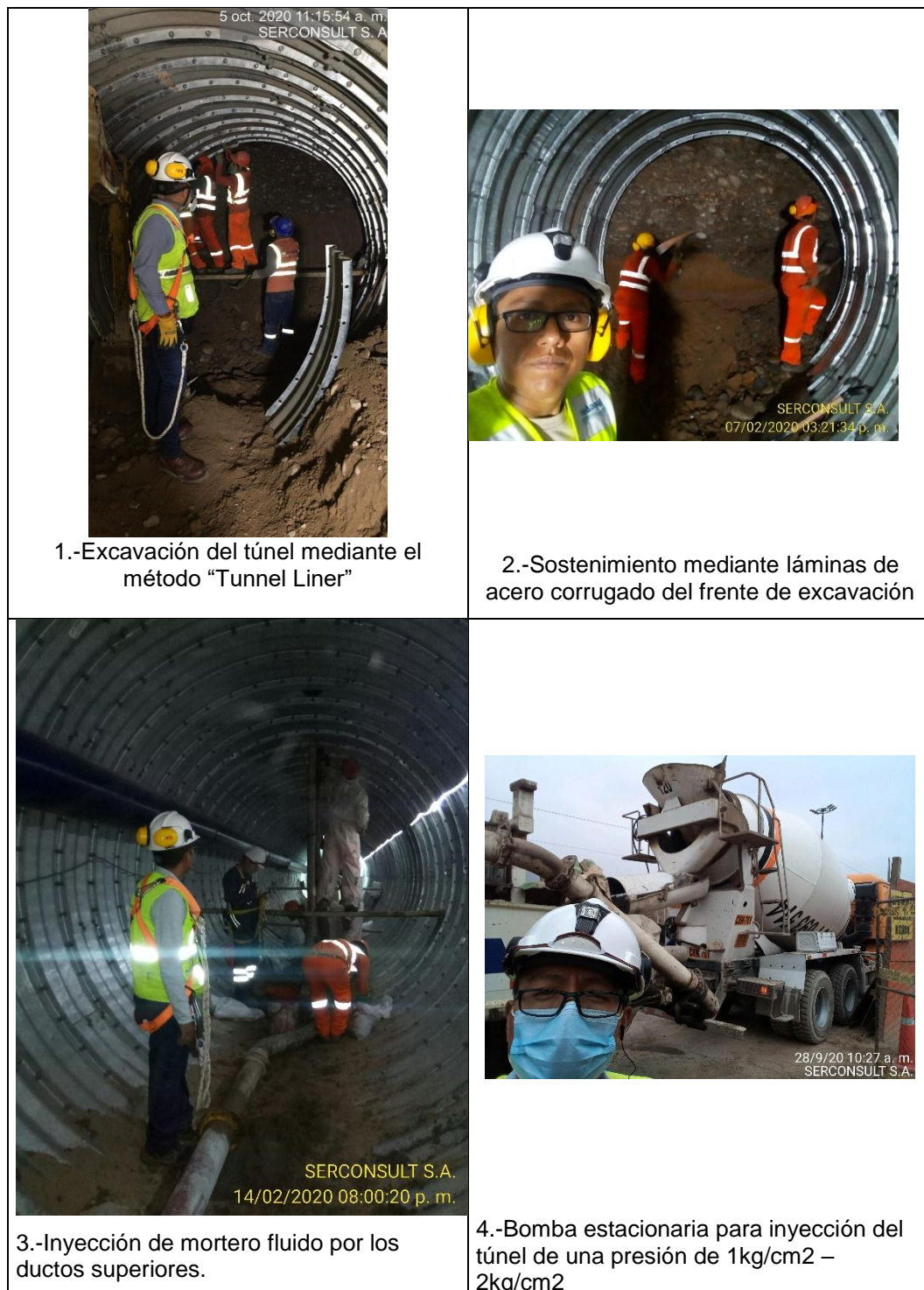
Figura B- 8.- Vista del proceso del método de excavación "Tunnel Liner" e inyección del mortero fluido.
