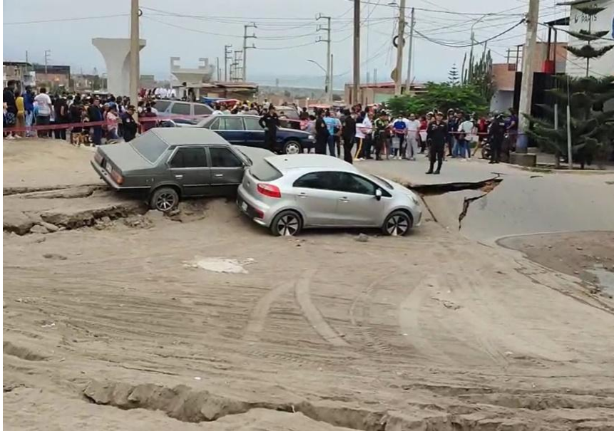
Figura N° 1: Hundimiento superficial de la vía panamericana km 80 – Megapuerto de Chancay.
