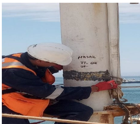
Junta 1 de mástil inspección visual aceptada.
