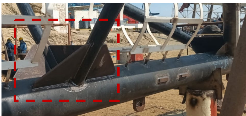
Figura 15- Unión entre el mástil y bípode
