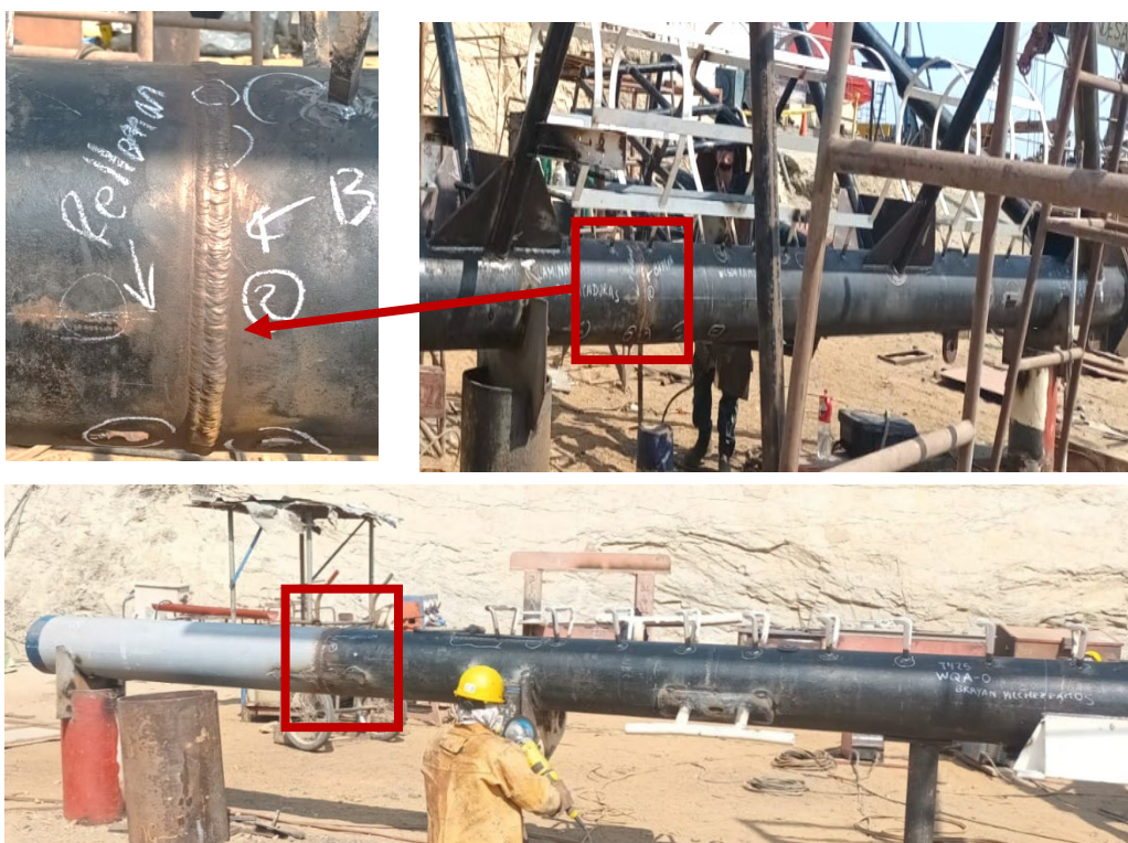
Figura 16- Unión soldada de las tuberías en el mástil
