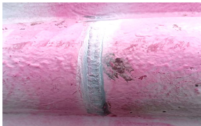
Figura 42- Verificando la soldadura con tintes penetrantes y ultrasonido
