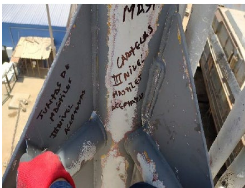
Juntas de cartelas y cartelas de mastil III nivel aceptadas.
