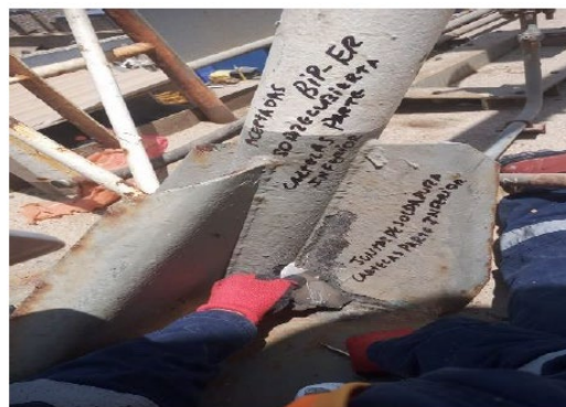
Parte inferior juntas de cartelas BIP-ER sobrecubierta aceptadas.
