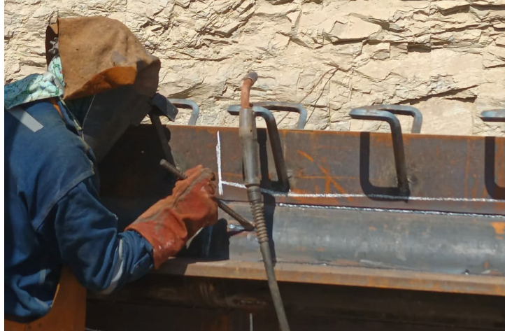
Figura 40- Soldador terminando de soldar venas verticales y pasando a soldar venas horizontales
