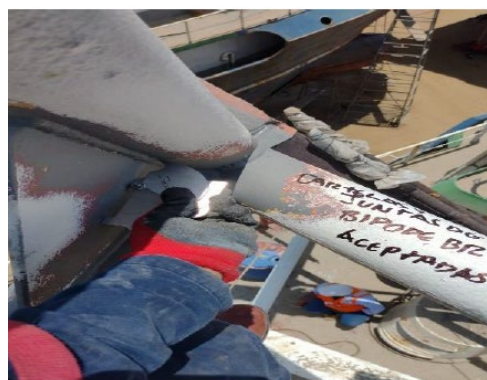
Juntas de cartelas y cartelas BIP-BR III nivel sobrecubierta aceptadas.
