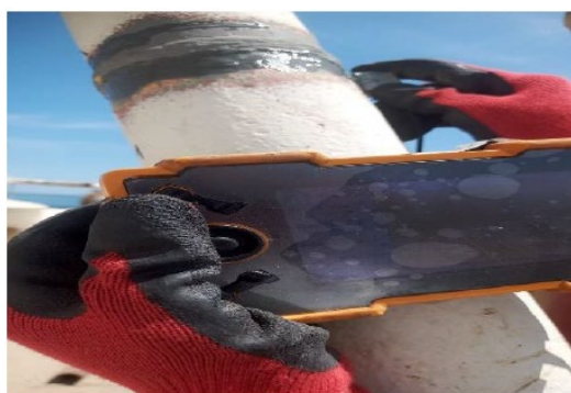
Junta 1 de BIP-ER inspección por ultrasonido industrial aceptada.
