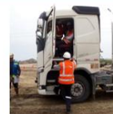
Se evalúa el estado del conductor
