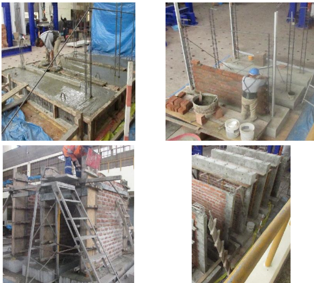
Figura 23. Construcción de los MAC, para la presente tesis
