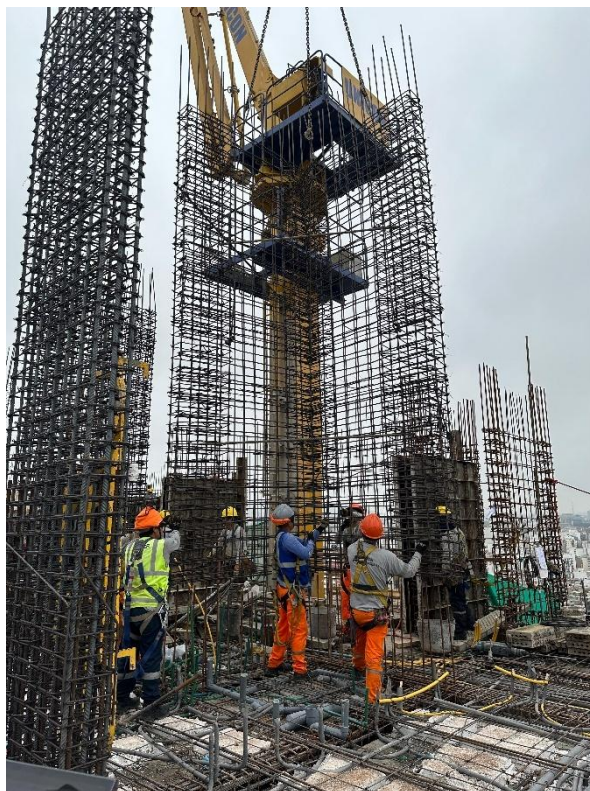
Fotografía 06. Colocación de placas ACEDIM® prearmado.
