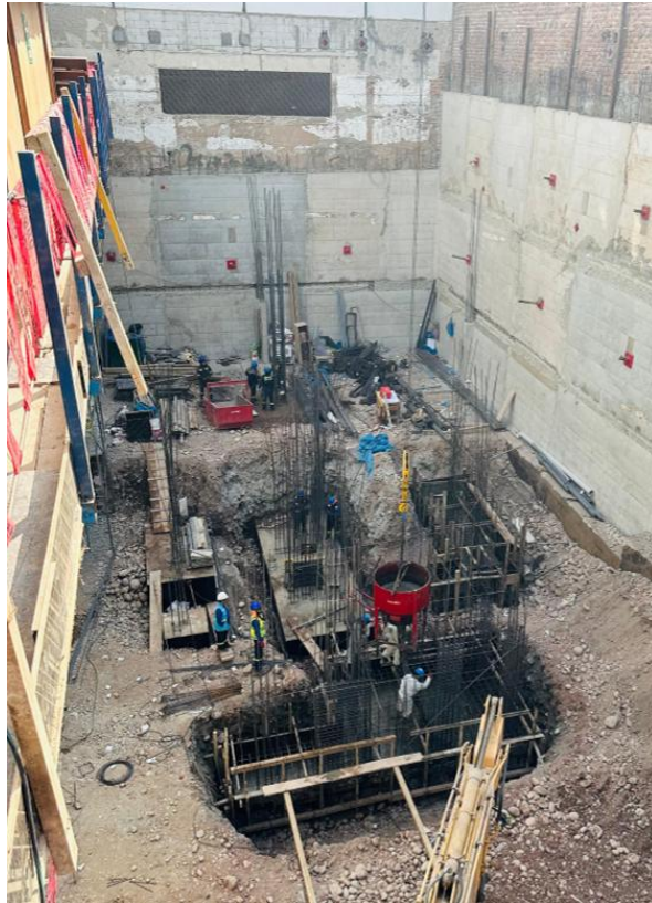
Fotografía 01. Armado de zapatas asiladas
