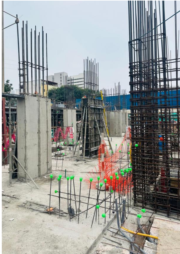
Fotografía 05. Armado elementos verticales en pisos superiores.
