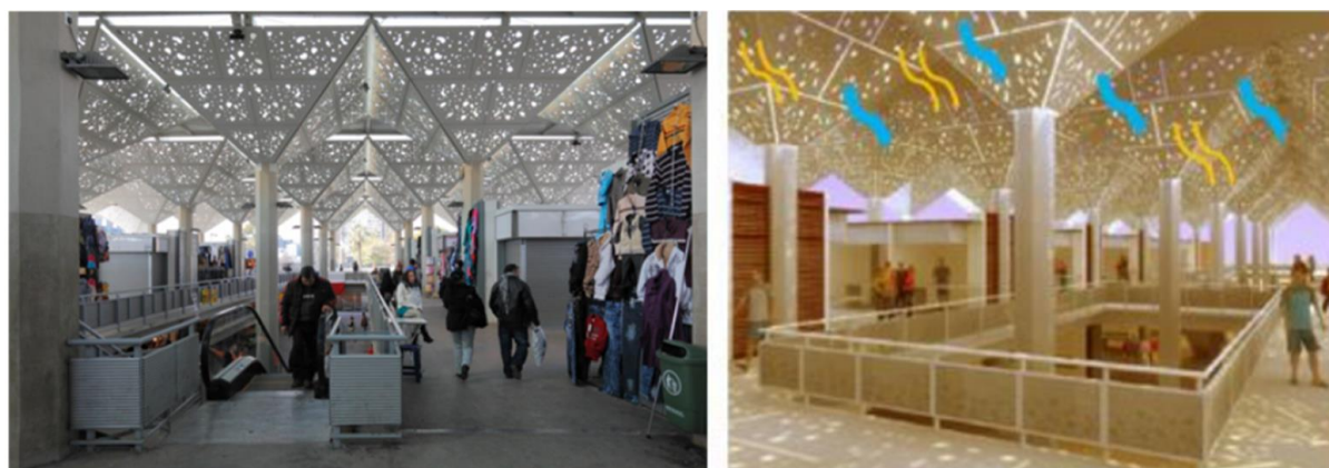
Figura 9. Vista interior la estructura del Mercado Tirso de Molina
