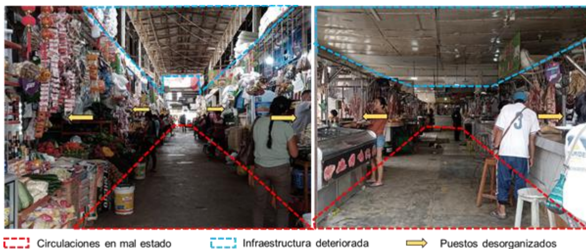
Figura 3. Estado actual de la infraestructura existente en el terreno de intervención
