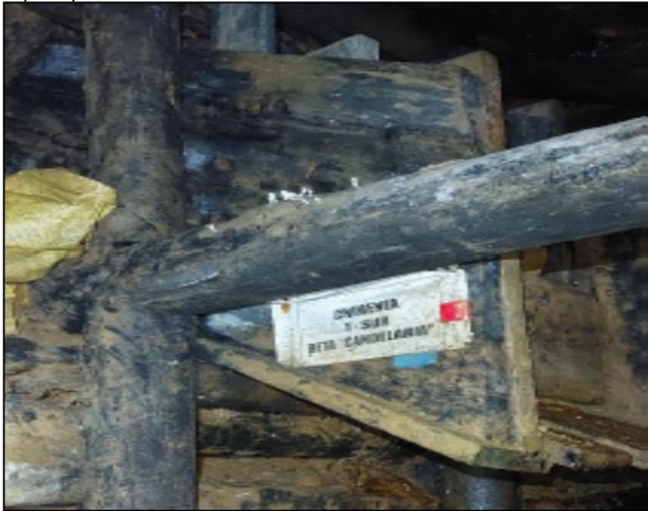
Chimenea principal de ventilación
