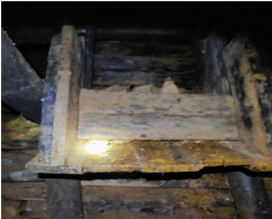
Fotografía de chimenea secundaria
