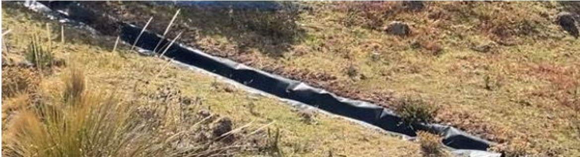
Sistema de drenaje superficial en el depósito de topsoil TS
