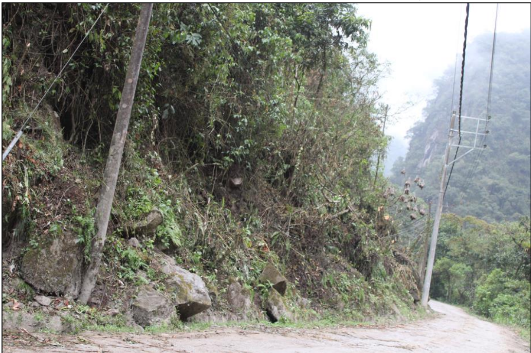
Vista de desbroce por servidumbre en línea MA02, desde punto M-6
