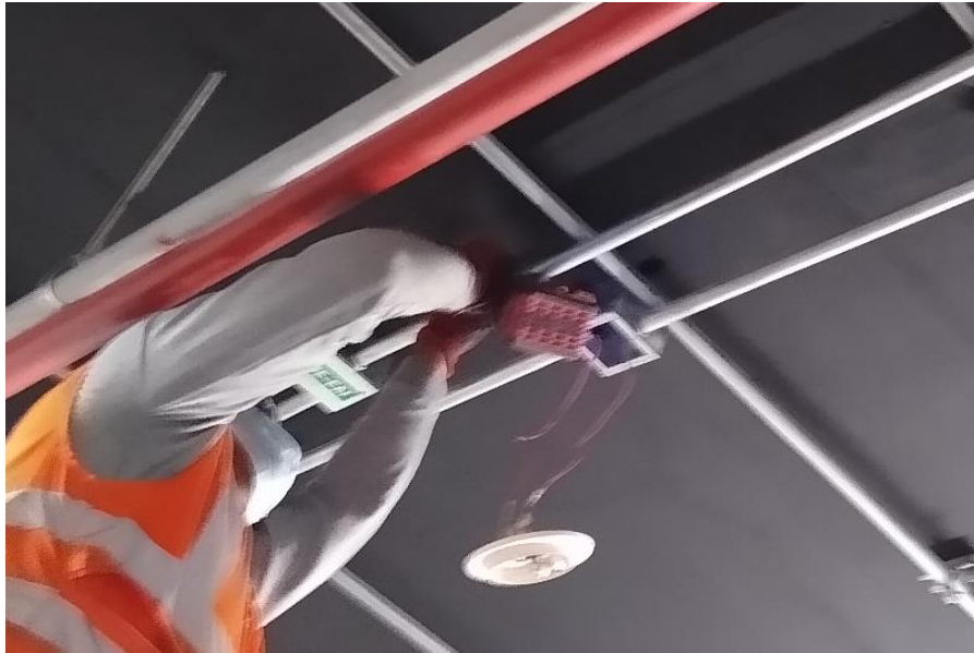
Fotografía 4. Instalacion de base de detector de humo.
