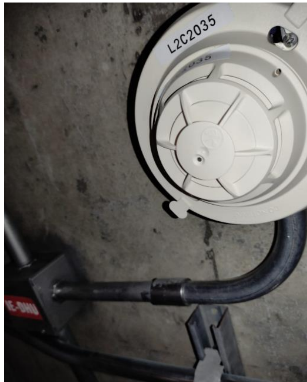
Fotografía 5. Instalacion de detector de humo y pruebas de funcionamiento.
