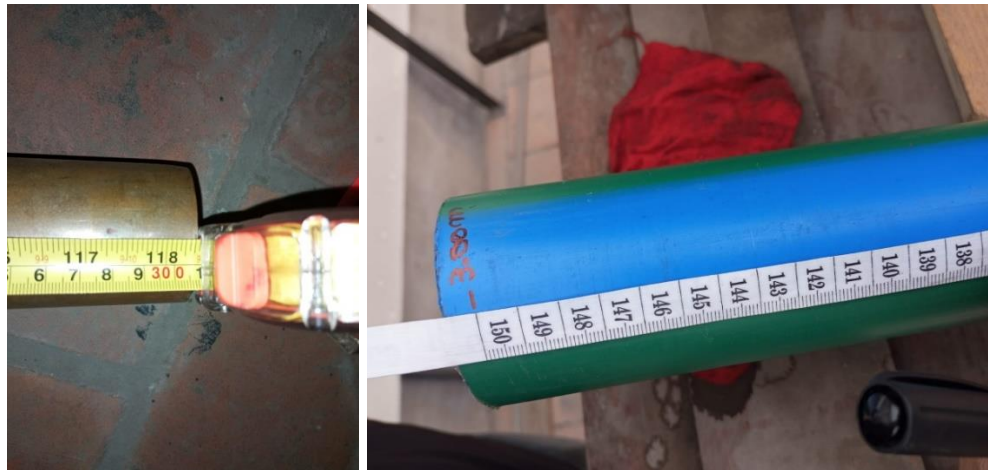
Utilización de guincha para la medición de las longitudes de las tuberías
