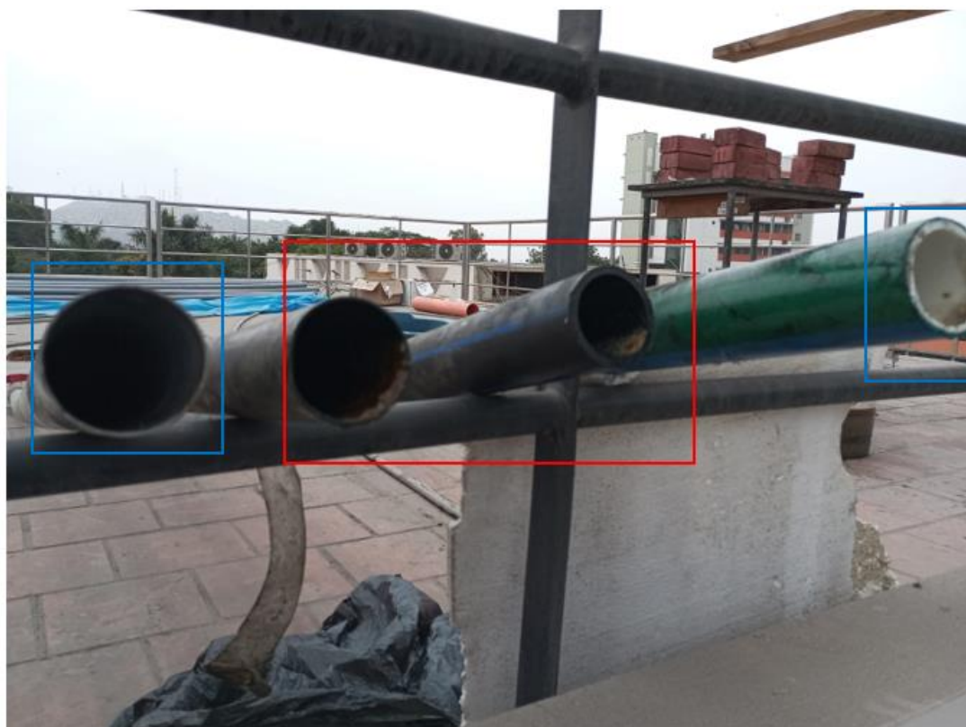
Figura 58 Tuberías al final de la tesis
