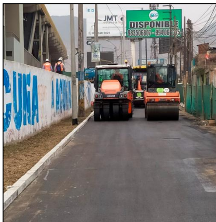
Rodillo tándem y neumático compactando en el tramo T-5
