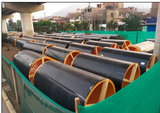
Almacenamiento de tuberías HDPE 1600 mm en el proyecto
