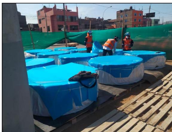
Almacenamiento de Acoples HDPE 1600 y 630 mm en almacén del proyecto
