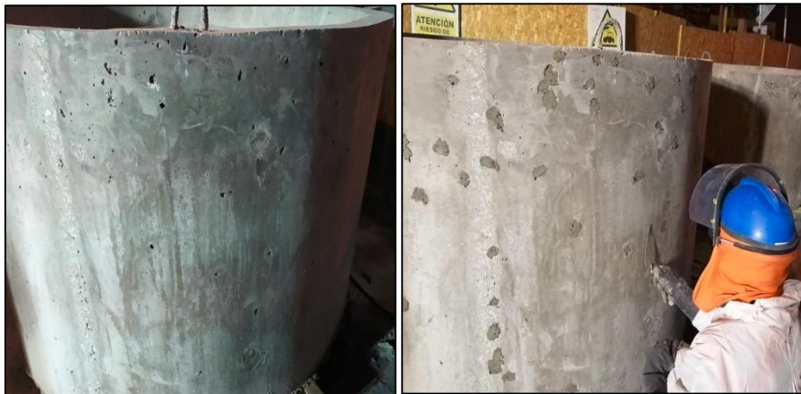
Figura N° 107 Reparación de porosidades en cuerpo prefabricado de buzón
