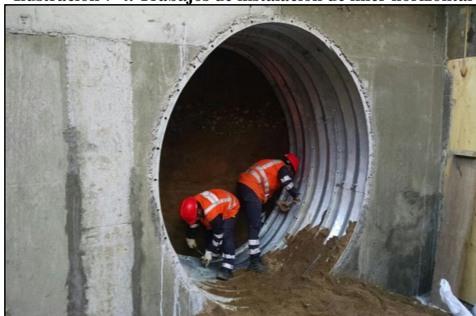
Ilustración 7-4. Trabajos de instalación de liner horizontal
