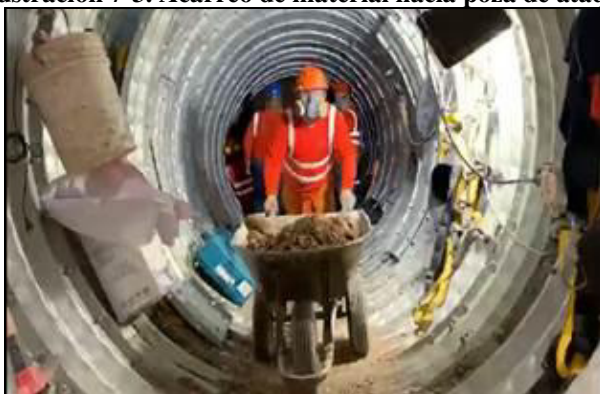
Ilustración 7-3. Acarreo de material hacia poza de ataque
