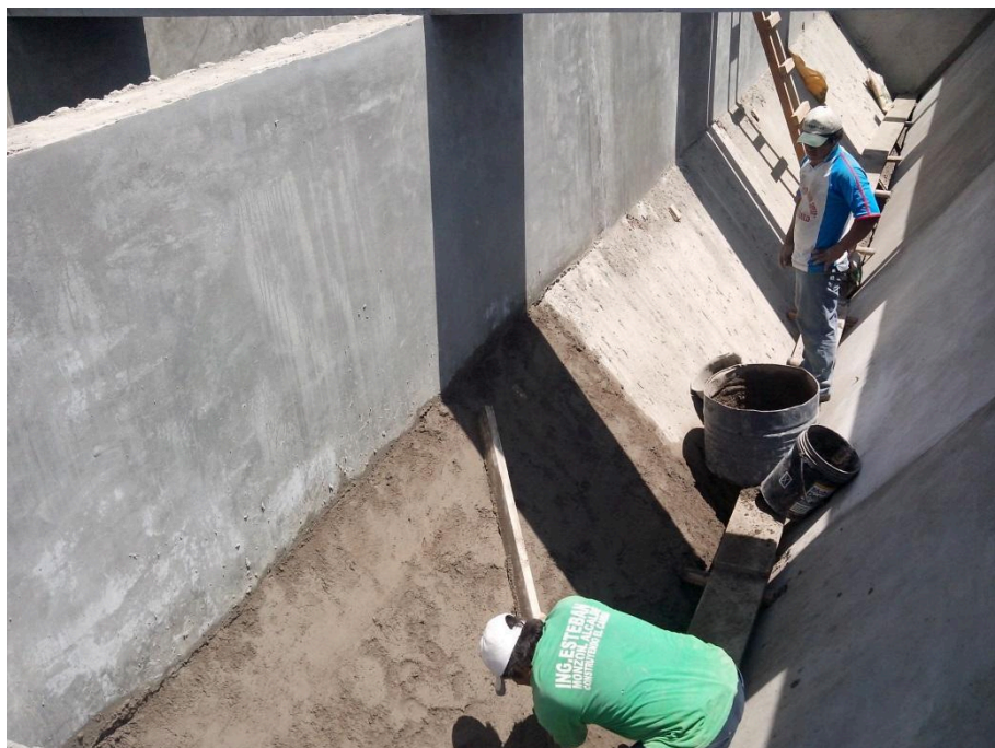
TARRAJEO INTERIOR DE MUROS EN TANQUE IMHOFF
