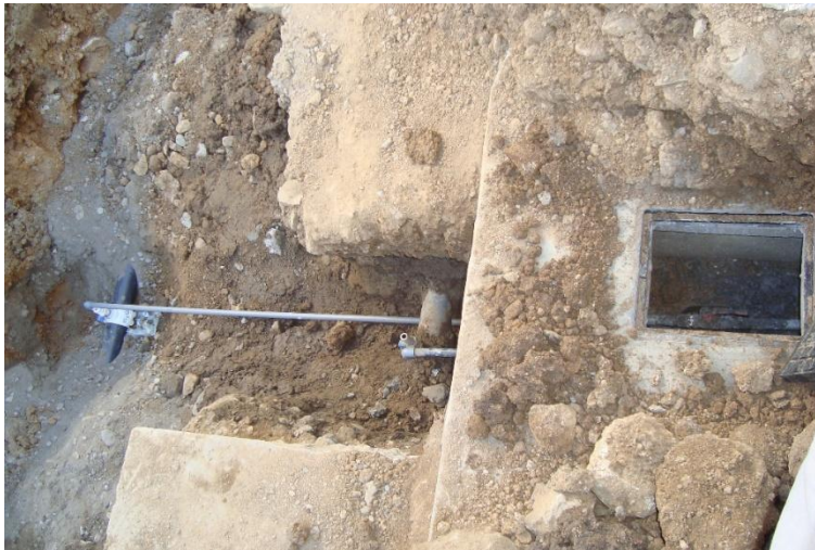
Instalación de red de agua alejada de la red existente
