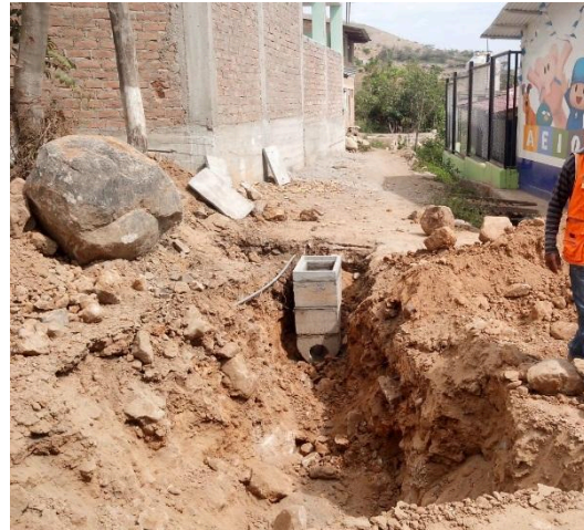
INSTALACIÓN DE CAJAS DE REGISTRO
