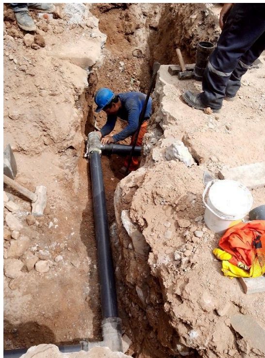
INSTALACIÓN DE REDES, ACCESORIOS DE AGUA POTABLE
