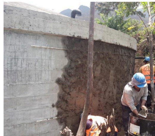
TARRAJEO DE RESERVORIO CIRCULAR
