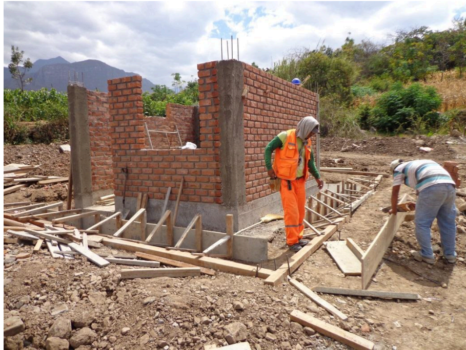
CONSTRUCCIÓN DE CASETA DE GUARDIANÍA Y ALMACÉN
