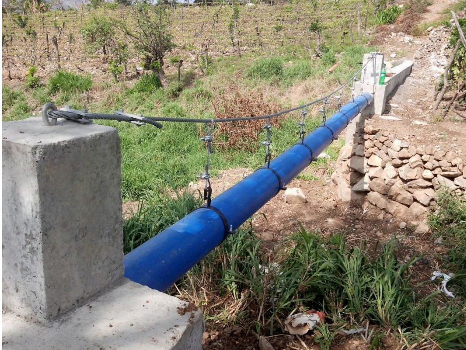
CONSTRUCCIÓN DE PASE AÉREO EN COLECTOR DN 250 mm
