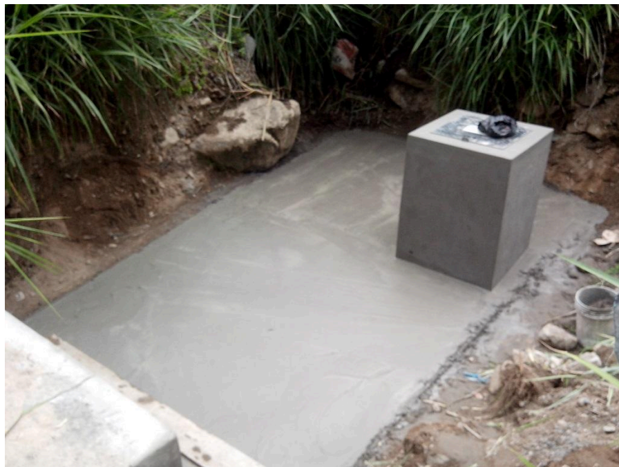
MEJORAMIENTO DE CAPTACION LOS CHIMBILES
