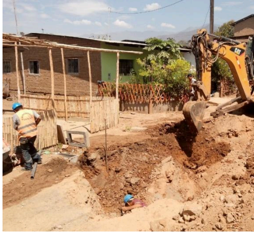
EXCAVACIÓN PARA CONEXIONES DOMICILIARIAS DE DESAGÜE
