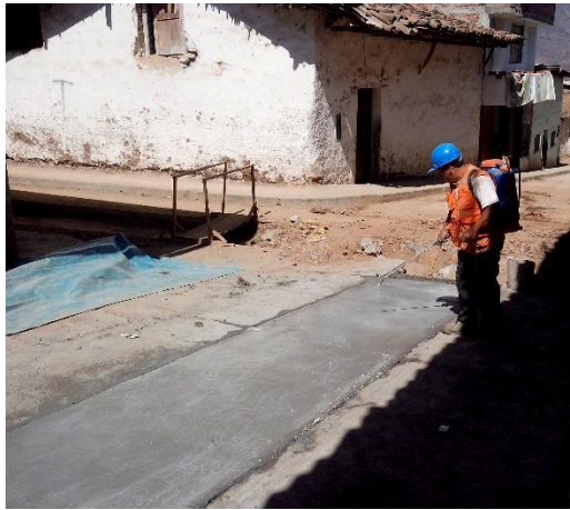
CURADO DE CONCRETO
