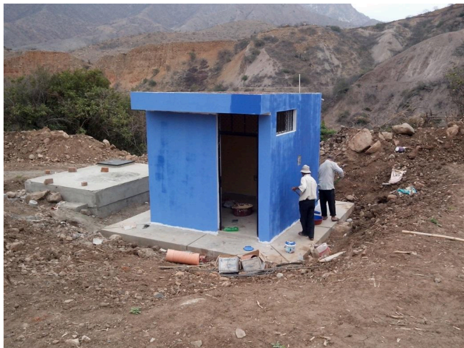
PINTADO DE CASETA DE CLORACIÓN
