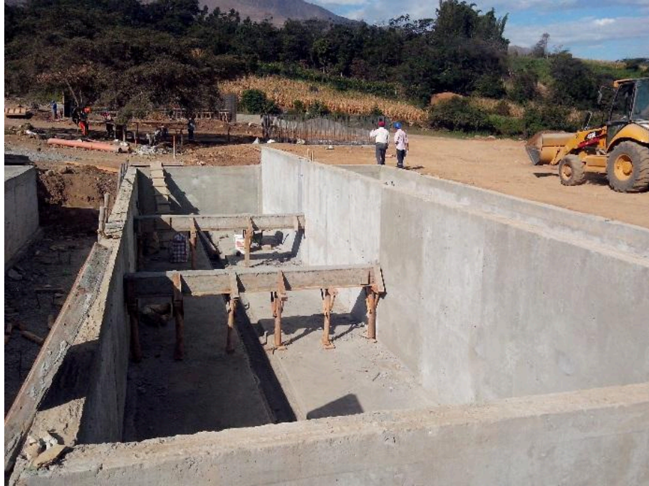
CONSTRUCCIÓN DE LECHOS DE SECADO
