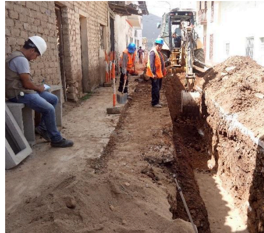
EXCAVACIÓN DE ZANJA C/MAQUINARIA
