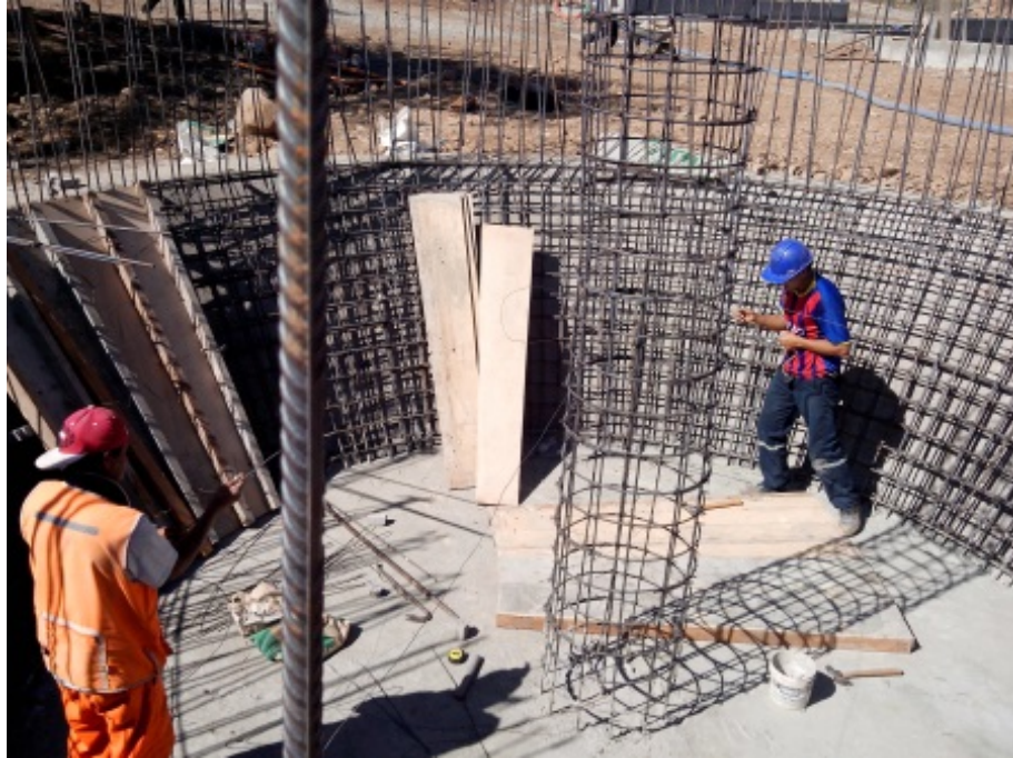
HABILITACIÓN DE ACERO DE COLUMNA CENTRAL DE SEDIMENTADOR DORTMUND
