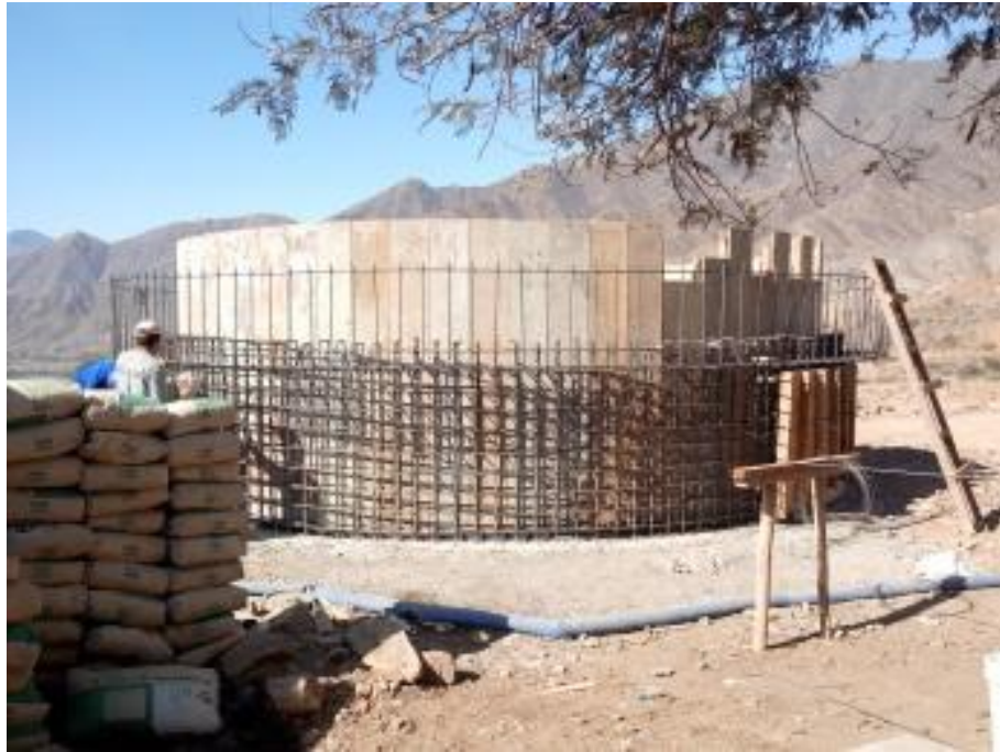
ENCOFRADO INTERIOR DE MUROS DE SEDIMENTADOR DORTMUND
