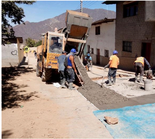
VACIADO DE CONCRETO
