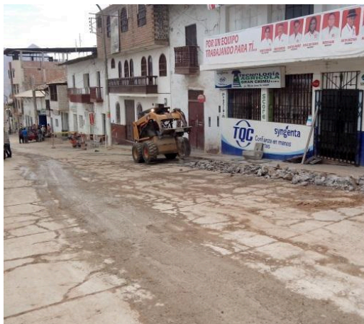
ROTURA DE PAVIMENTOS
