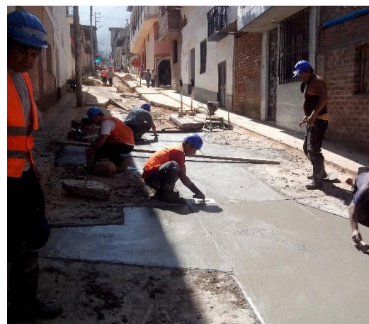
ACABADO DE PAVIMENTO
