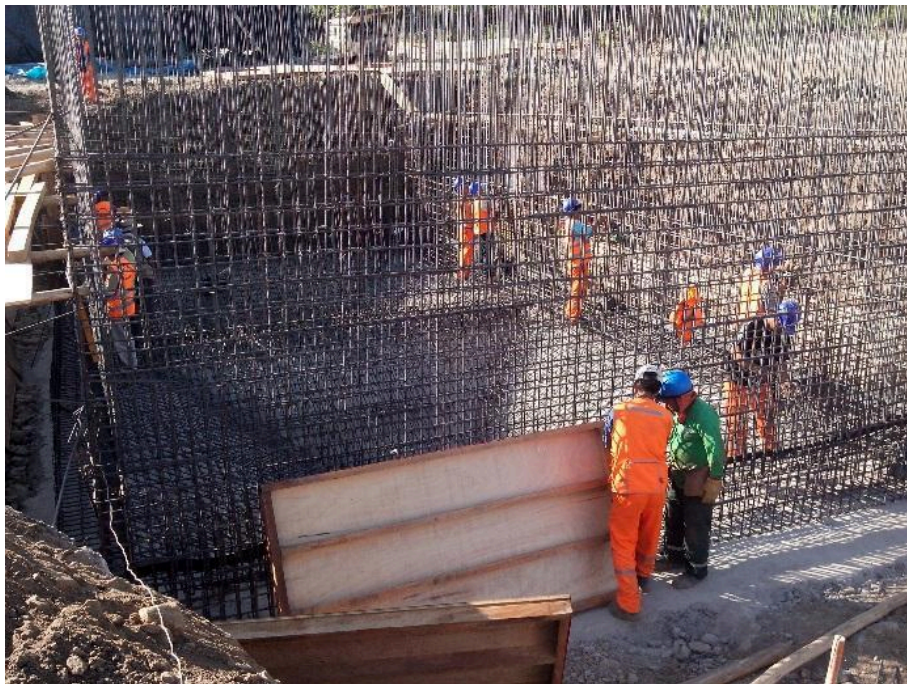
ENCOFRADO PARA MUROS DE TANQUE IMHOFF
