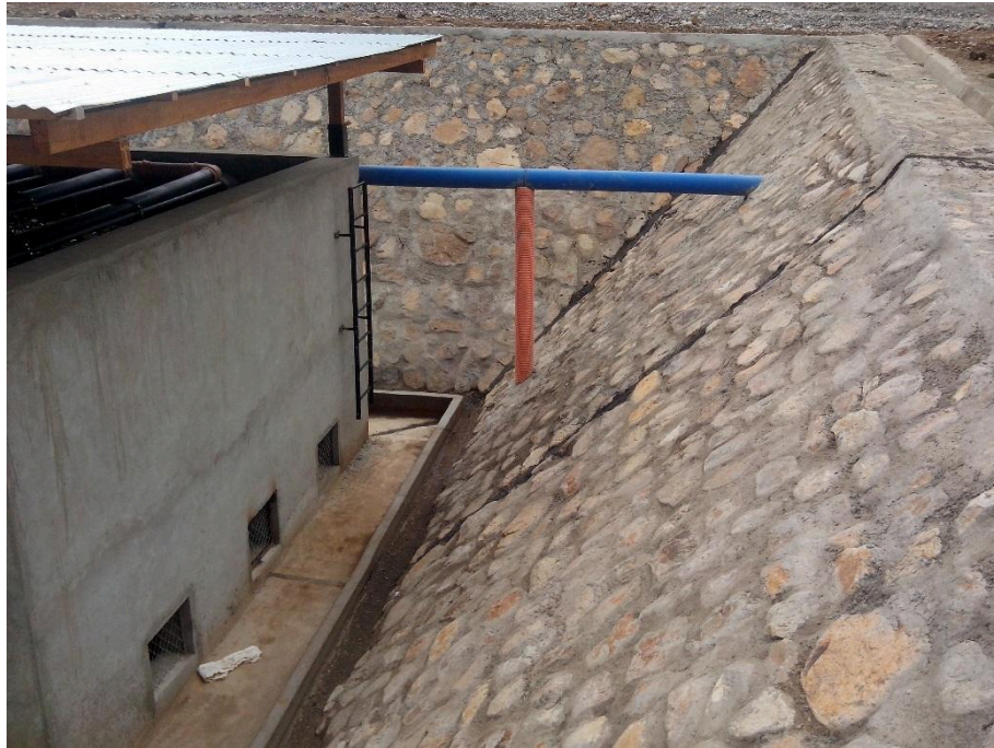
TALUD DE MAMPOSTERÍA DE PIEDRA EN FILTRO PERCOLADOR
