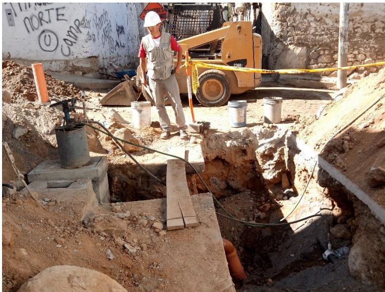
Prueba hidráulica de redes de distribución de agua potable
