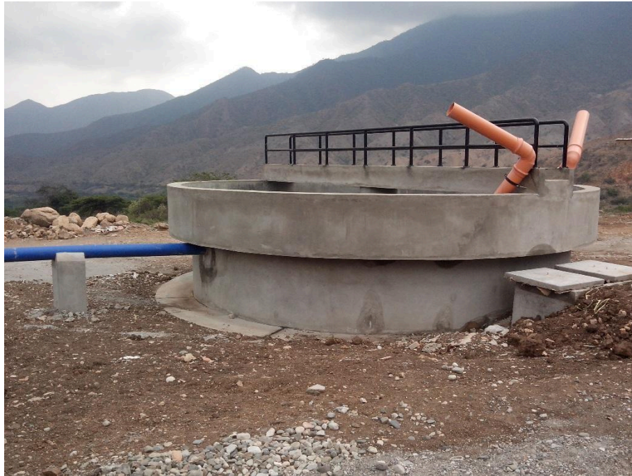
SEDIMENTADOR DORTMUND TERMINADO
