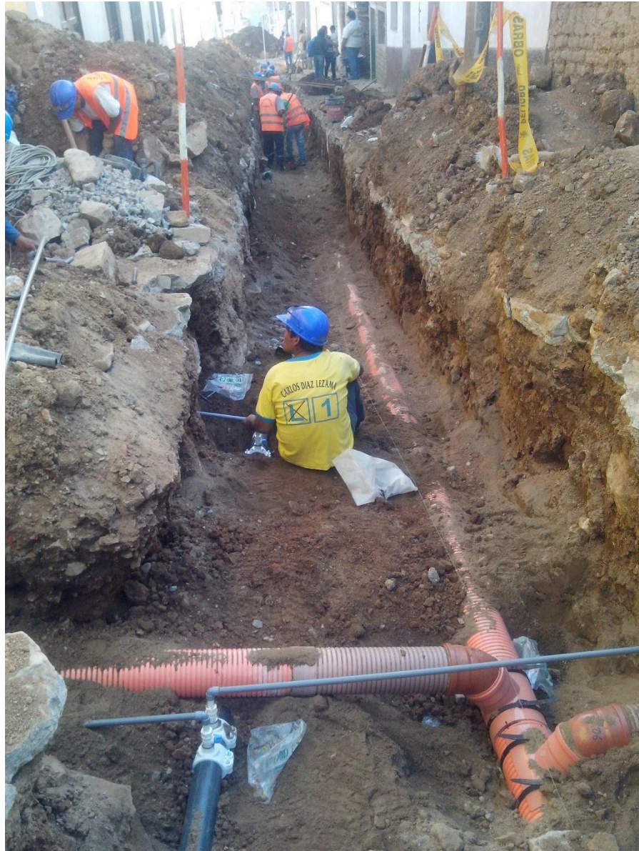
INSTALACIÓN DE CONEXIONES DOMICILIARIAS EN REDES DE AGUA POTABLE Y ALCANTARILLADO
