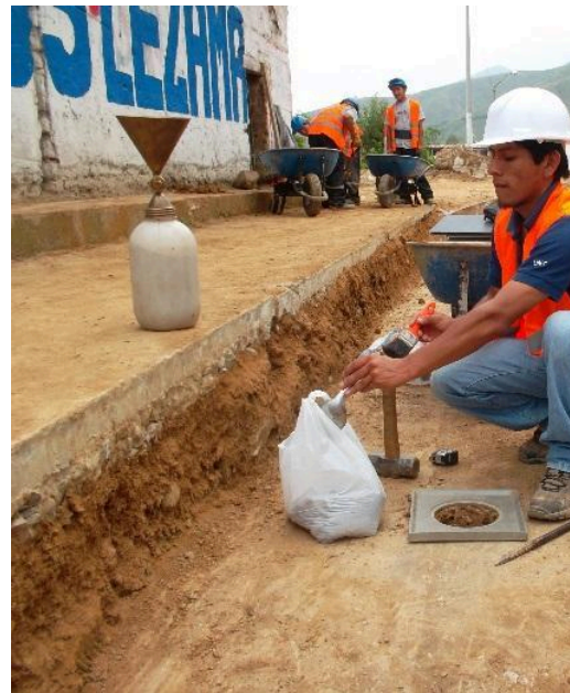
ENSAYOS DE COMPACTACIÓN
