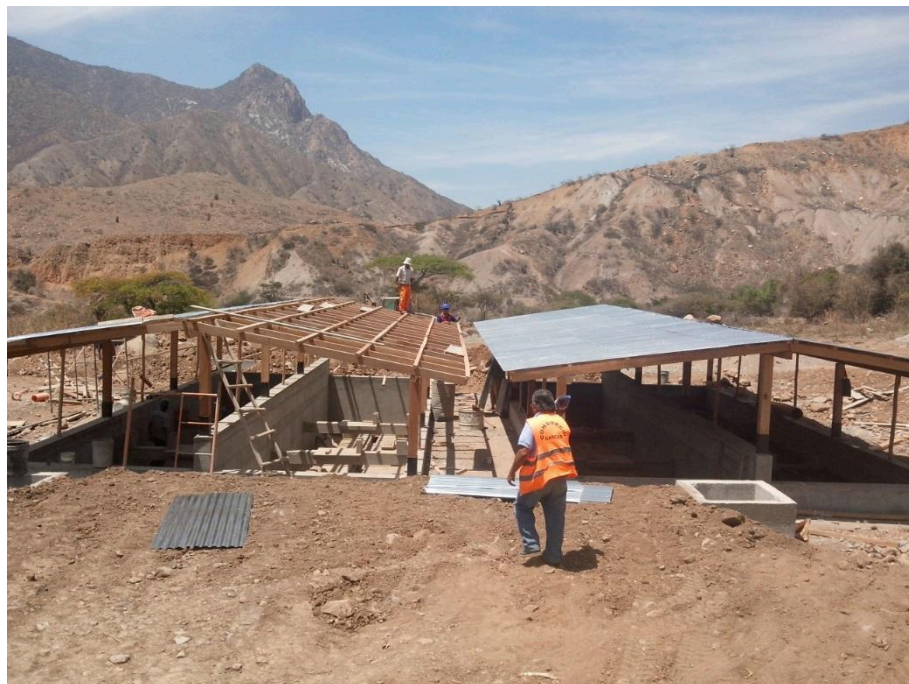
CONSTRUCCION DE TECHOS EN LECHOS DE SECADO
