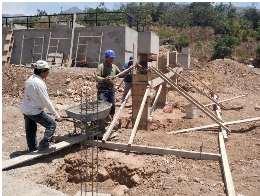
CONSTRUCCION DE COLUMNAS DE APOYO PARA TUBERÍA HDPE ENTRE TANQUE IMHOFF Y SEDIMENTADOR DORTMUND
