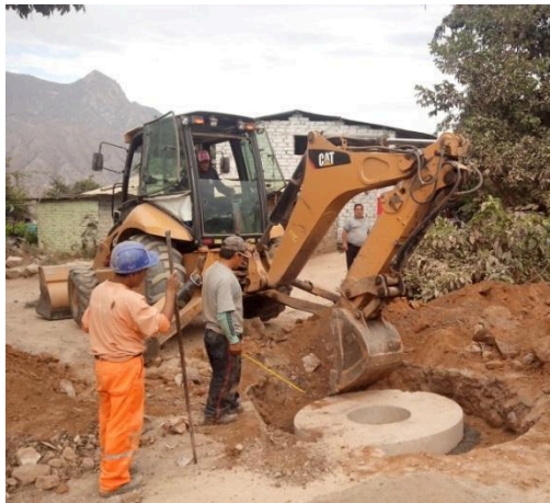
INSTALACIÓN DE BUZONES
