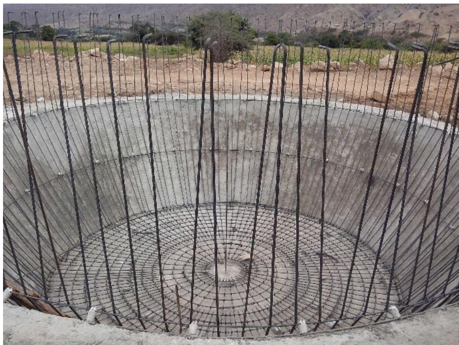
HABILITACIÓN DE ACERO PARA MUROS DE SEDIMENTADOR DORTMUND
