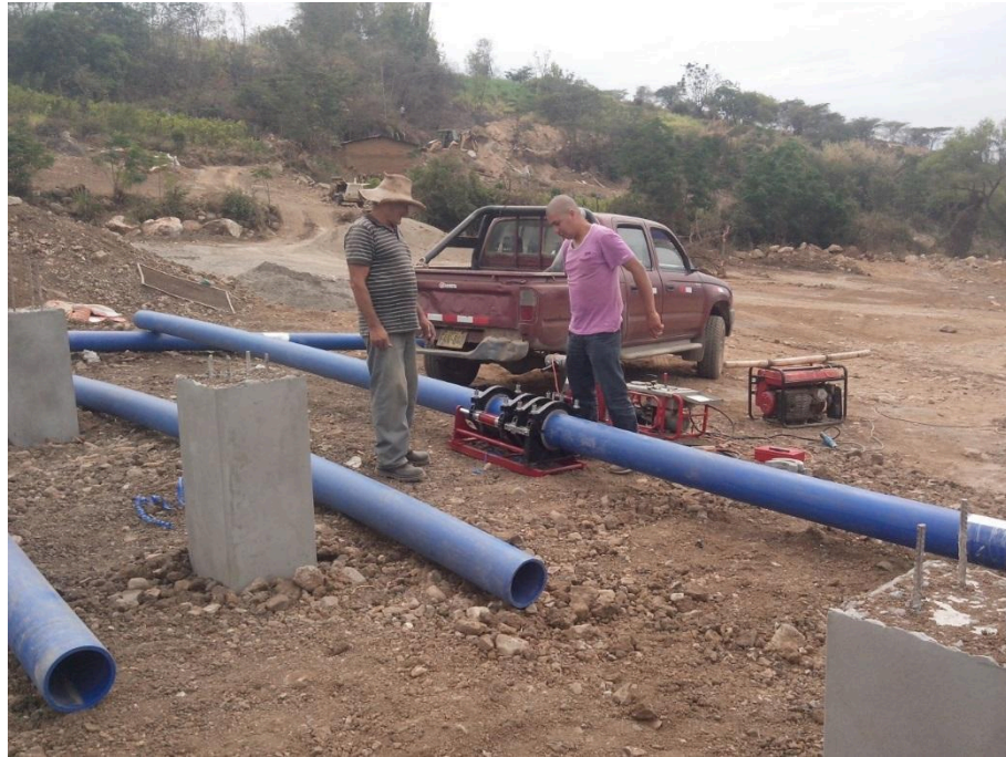
UNION DE TUBERIA HDPE DN200mm POR TERMOFUSIÓN
