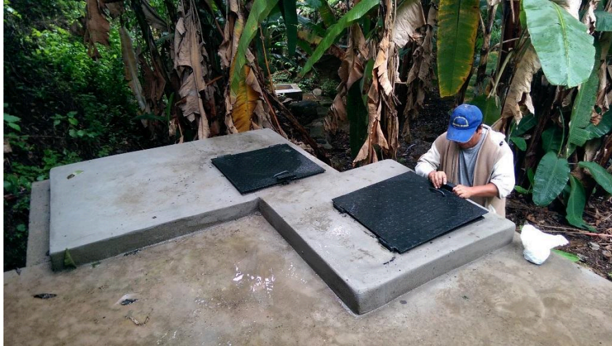
MEJORAMIENTO DE CAPTACIÓN PLATANAR (TARRAJEO E INSTALACIÓN DE TAPAS SANITARIAS)
