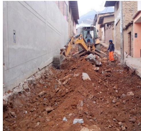
EXCAVACIÓN A NIVEL DE SUBRASANTE
