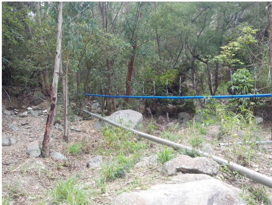
CONSTRUCCIÓN DE PASE AÉREO LOS CHIMBILES DN110mm
