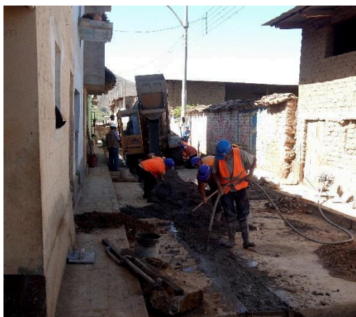
VACIADO DE CONCRETO
