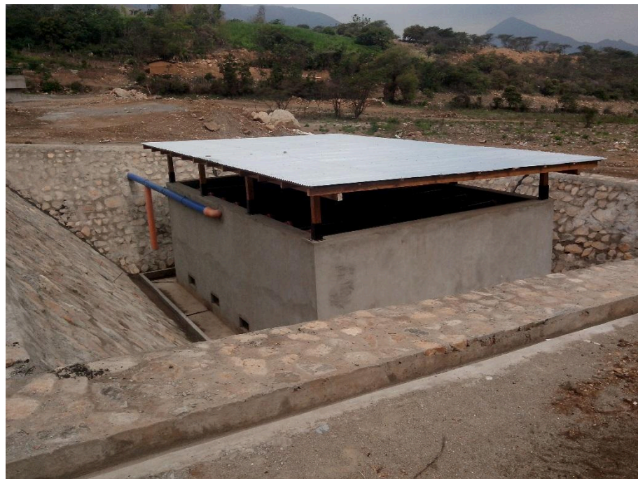
VISTA DE FILTRO PERCOLADOR TERMINADO
