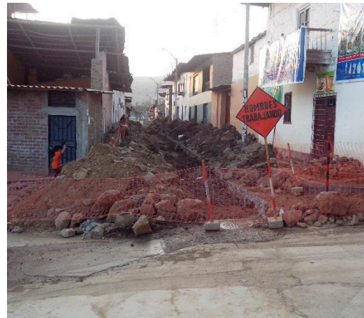
SEÑALIZACIÓN EN OBRA
