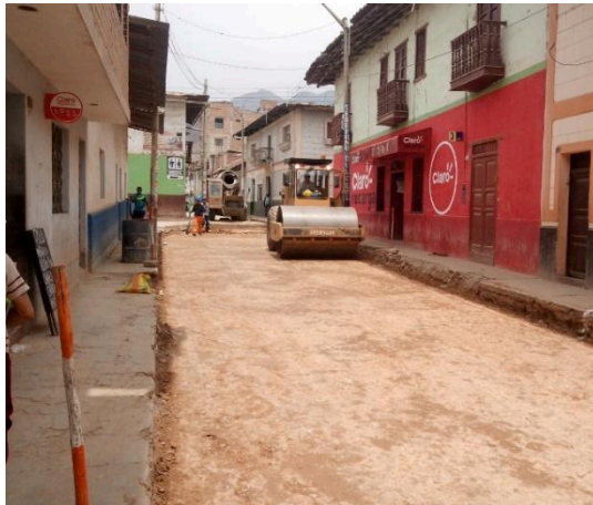
COMPACTACIÓN DE BASE CON EQUIPO
