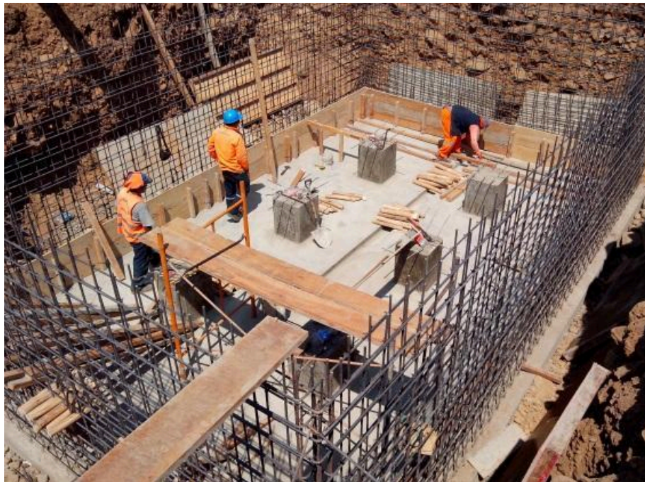
HABILITACIÓN DE ACERO Y ENCOFRADO DE MUROS DE FILTRO PERCOLADOR
