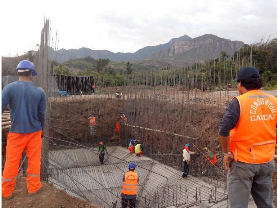
HABILITACIÓN DE ACERO PARA LOSA DE FONDO DE TANQUE IMHOFF
