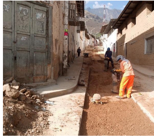
COMPACTACIÓN DE BASE (AFIRMADO)
