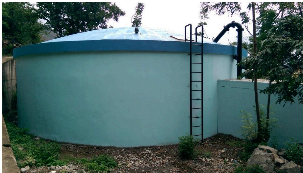
MEJORAMIENTO DE RESERVORIO CIRCULAR (PINTADO)
