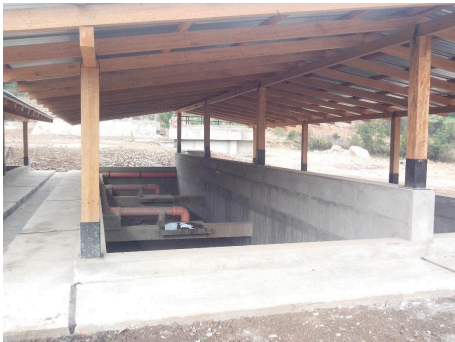
INSTALACIÓN DE REDES INTERIORES DE LECHOS DE SECADO
