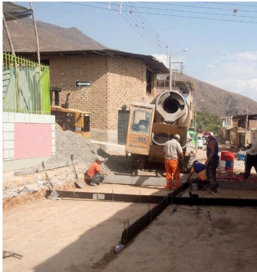
ENCOFRADO PARA PAVIMENTACIÓN
