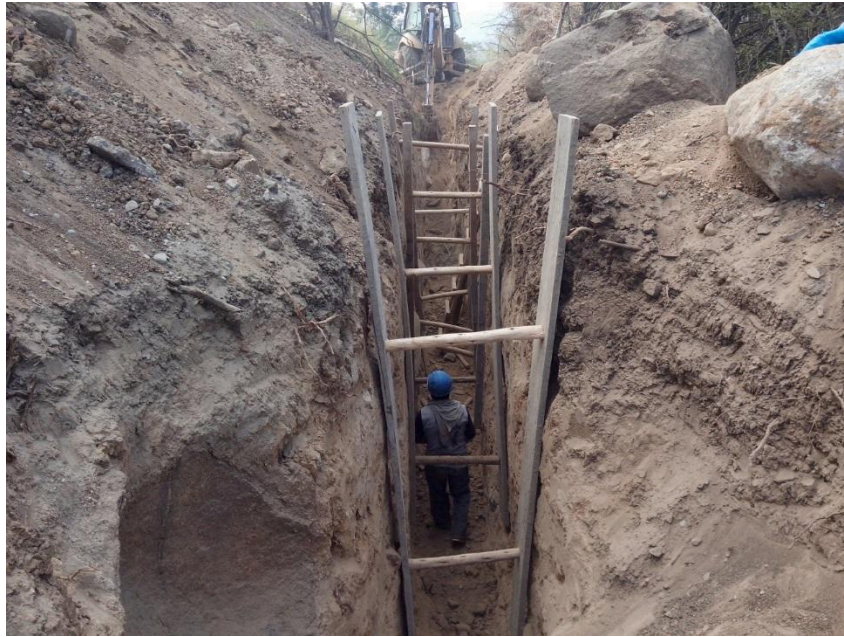
ENTIBADO DE ZANJAS
