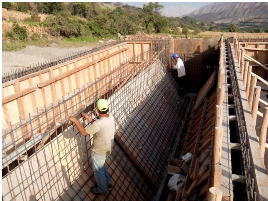
HABILITACIÓN DE ACERO Y ENCOFRADO DE MUROS INTERIORES DE TANQUE IMHOFF
