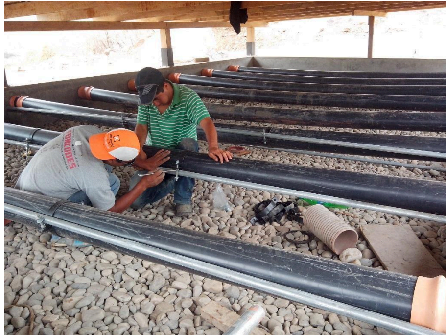
INSTALACION DE TUBERIA PERFORADA EN FILTRO PERCOLADOR
