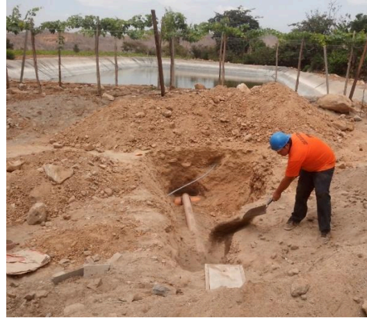
RECUBRIMIENTO DE TUBERIA DE DESAGUE
