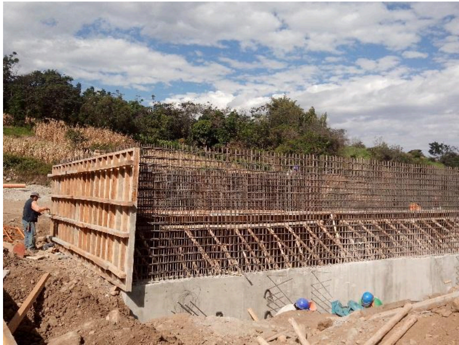
ENCOFRADO EXTERIOR PARA MUROS DE TANQUE IMHOFF
