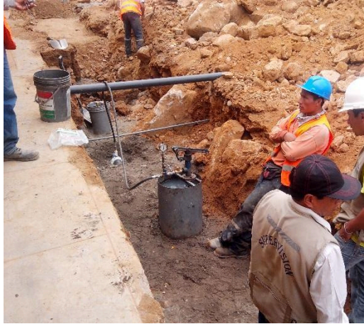
PRUEBAS HIDRÁULICAS
