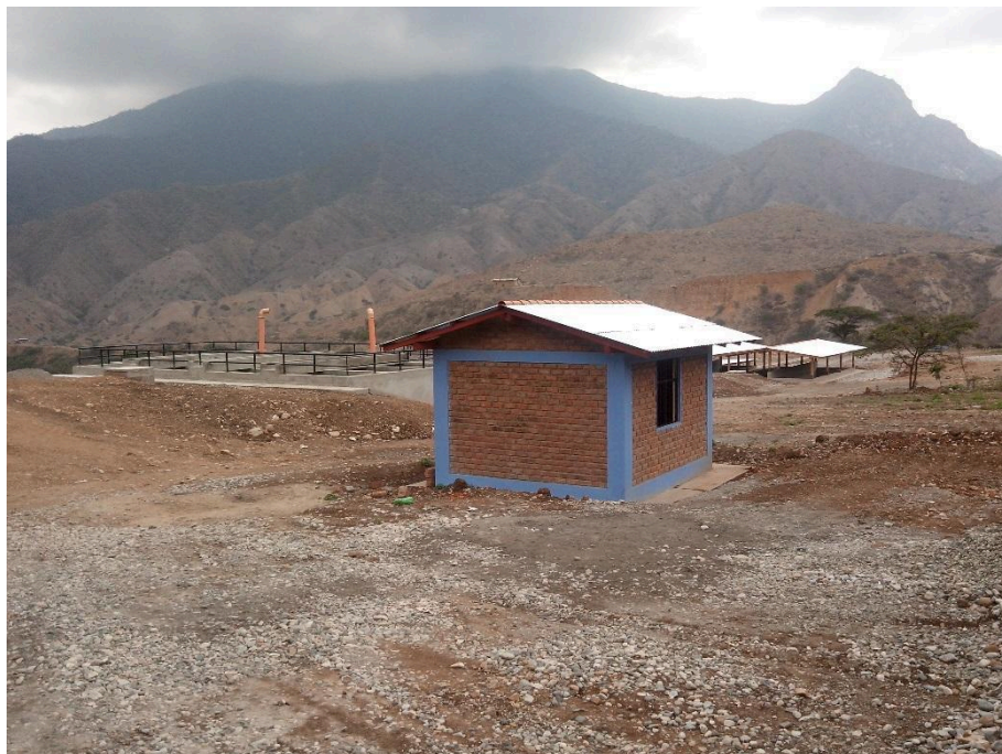
VISTA DE CASETA DE GUARDIANÍA Y ALMACÉN FINALIZADA
