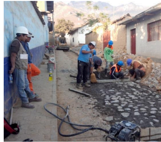
REPOSICIÓN DE MAMPOSTERÍA
