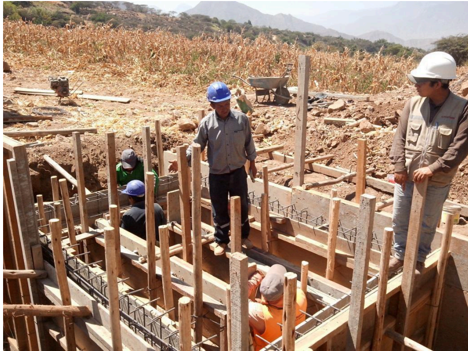
ENCOFRADO DE MUROS EXTERIORES E INTERIORES DE CÁMARA DE CONTACTO DE CLORO
