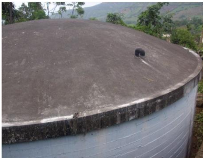
Reservorio Circular existente
