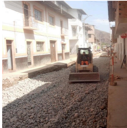
MEJORAMIENTO DE TERRENO
