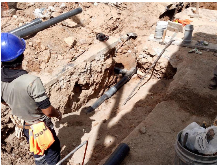
Instalación de tuberías y accesorios de agua potable
