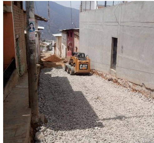
MEJORAMIENTO DE TERRENO
