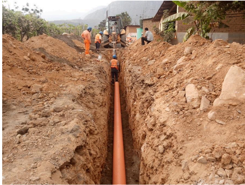
INSTALACIÓN DE REDES DE ALCANTARILLADO
