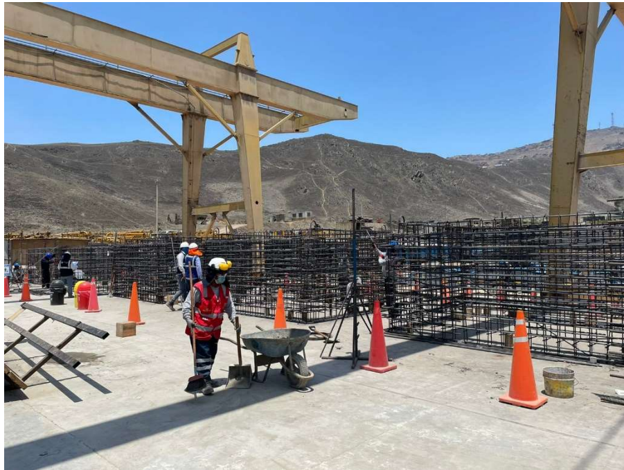
Prefabricado vaciado en posición vertical
