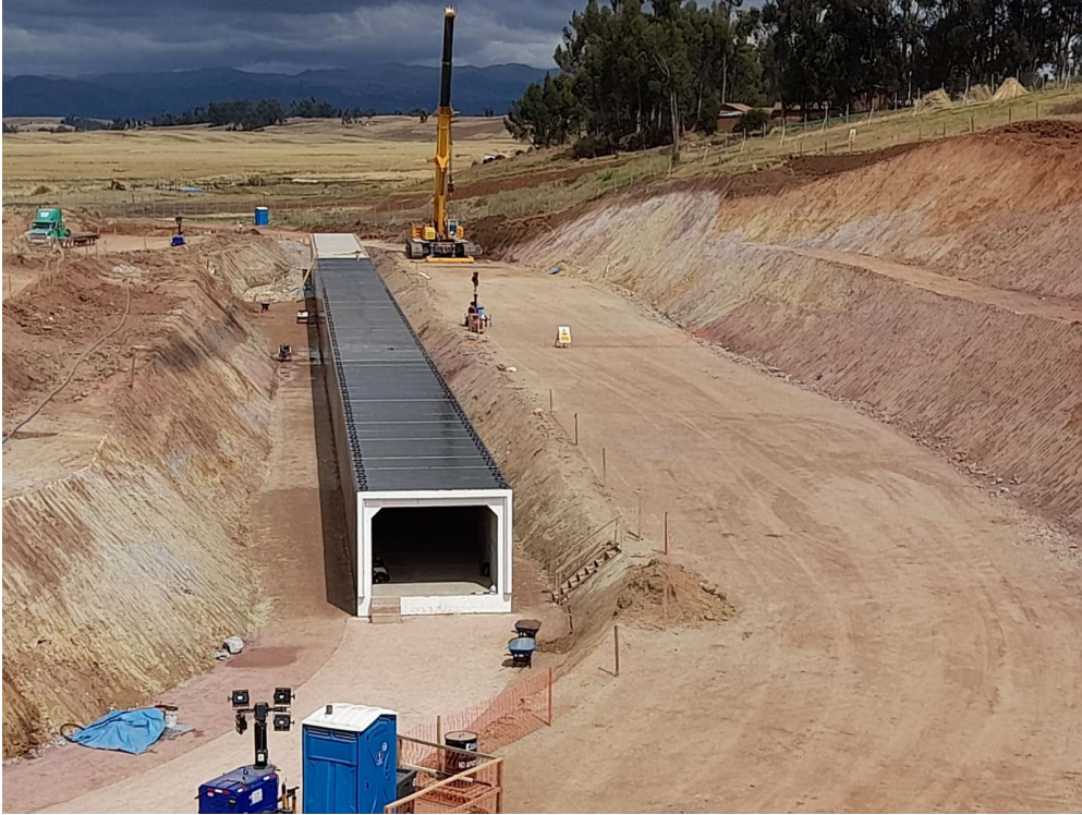
Montaje de módulos prefabricados en posición final en obra
