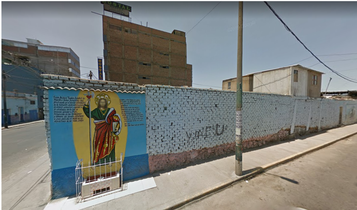
Ilustración 2: Intersección Jr. Lucanas con Calle Misti. Imagen Google Street View (2015).
