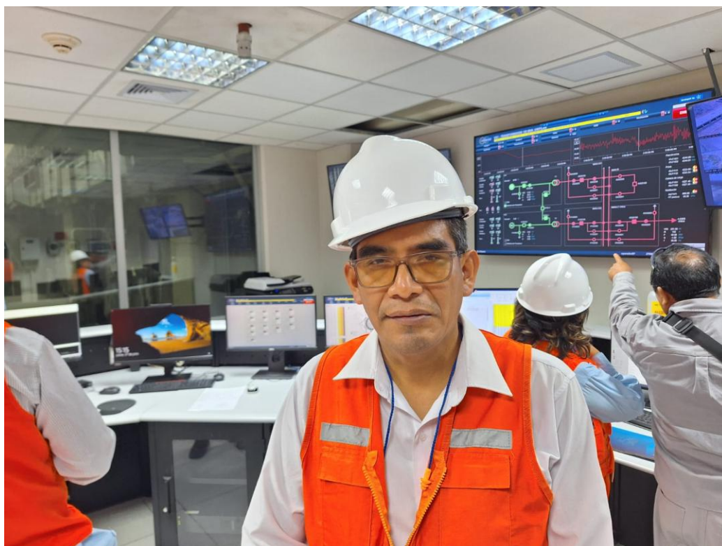
Figura 4.6: Sala de control de la central hidroeléctrica de El Platanal
