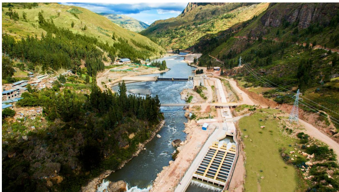
Figura 4.1: Río Cañete asimismo desarenador de central hidroeléctrica El Platanal
